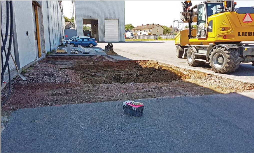
Figur 6. Transformator-schaktet sett från norr. Av bilden framgår att olika delar av schaktet grävdes ner till olika djup. Foto Ann-Charlott Feldt, ÖM.
