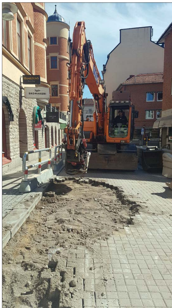
Figur 11. Schakt 1113:1 och 1113:2. Foto från väster, Helén Romedahl, ÖM.
