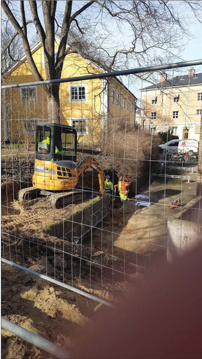
Figur 10. Schaktning för trappa. Foto från söder, Helén Romedahl, ÖM
