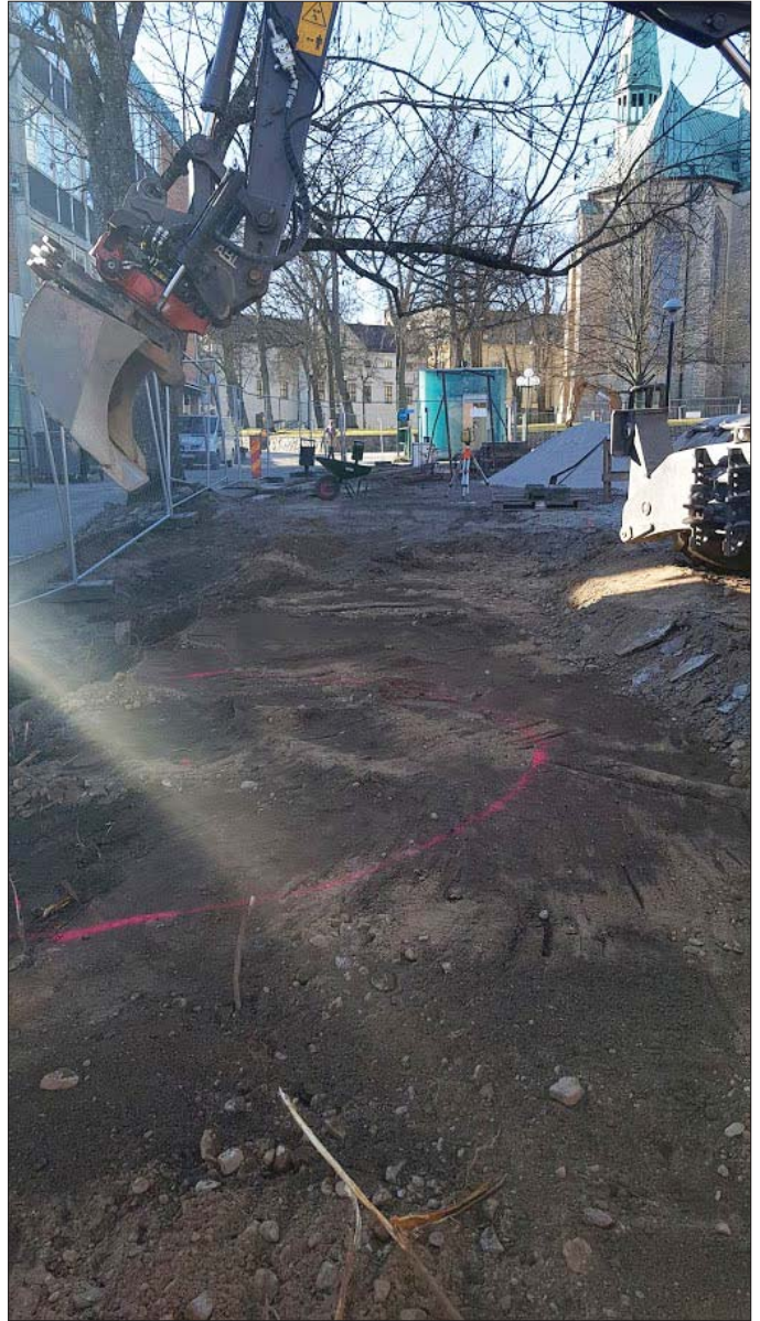
Figur 11. Inför schaktning av trädgrop. Foto från norr, Helén Romedahl, ÖM.
