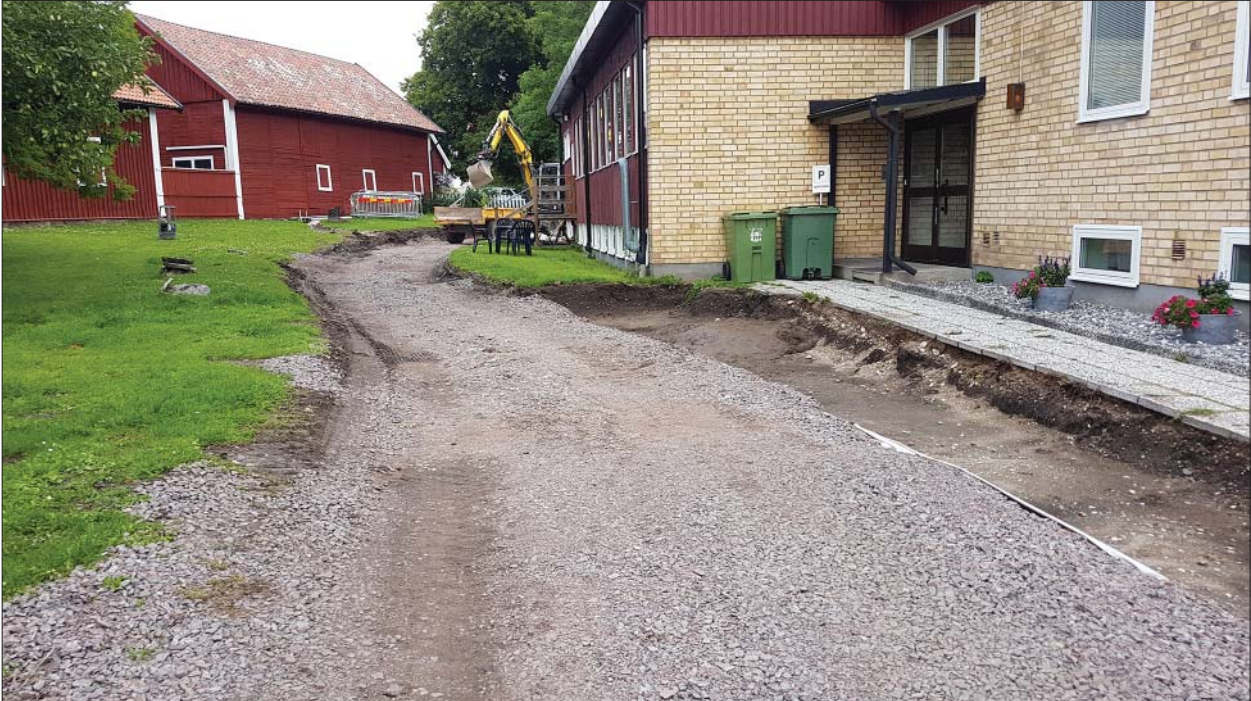
Figur 14. Sydligaste delen av schaktet sett från söder. Foto: Ann-Charlott Feldt, ÖM.
