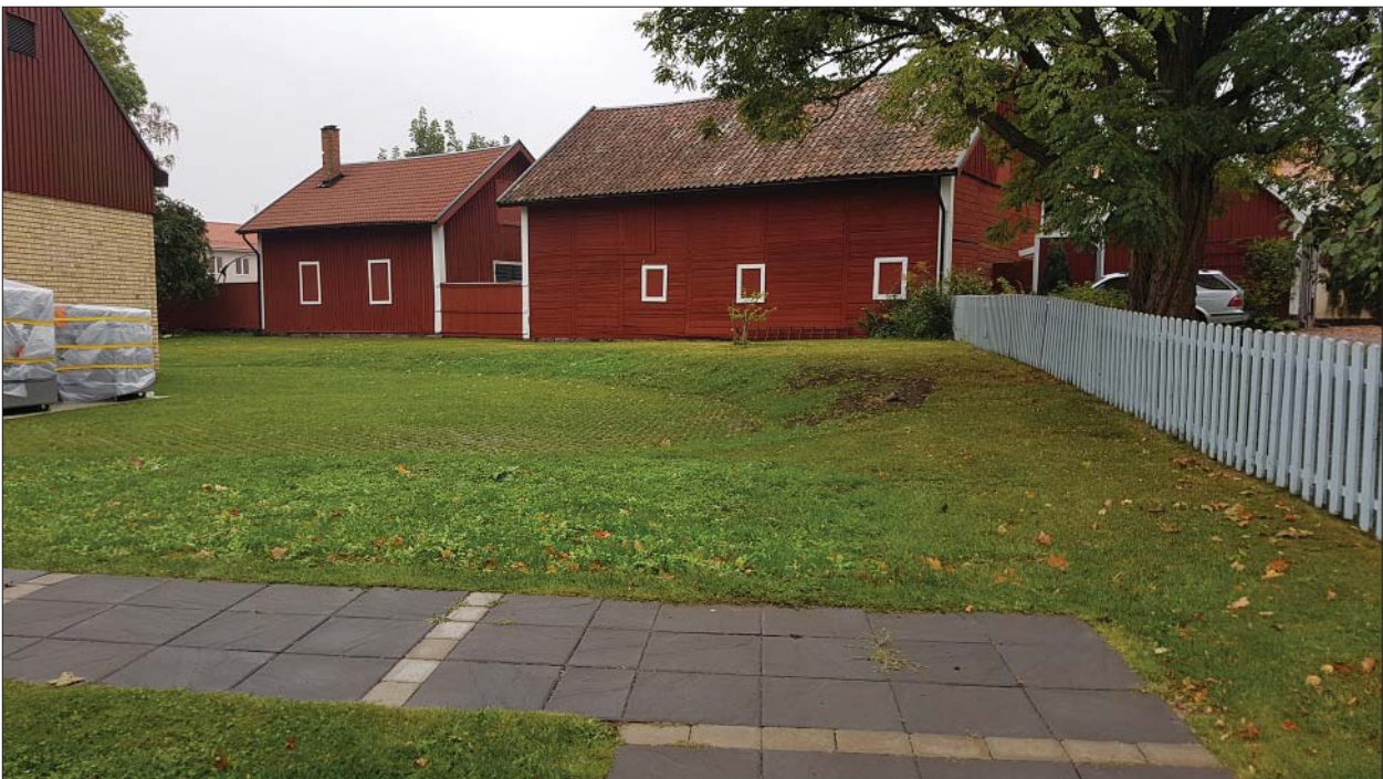
Figur 15. Färdigställd yta efter avslutat arbete sedd från öster. Foto: Ann-Charlott Feldt, ÖM.
