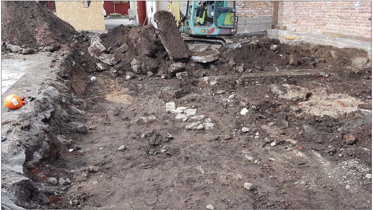
Figur 8. Stengrunden sedd från öster. Till höger i bild syns fundamenten till den rivna byggnaden. Foto Ann-Charlott Feldt, ÖM.
