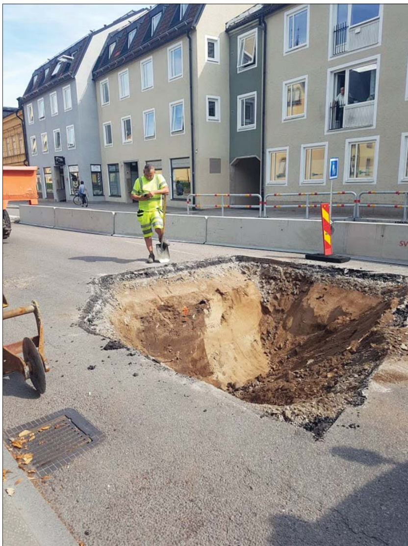
Figur 7. Schaktet i gatan. Foto mot öster, Helén Romedahl, ÖM.
