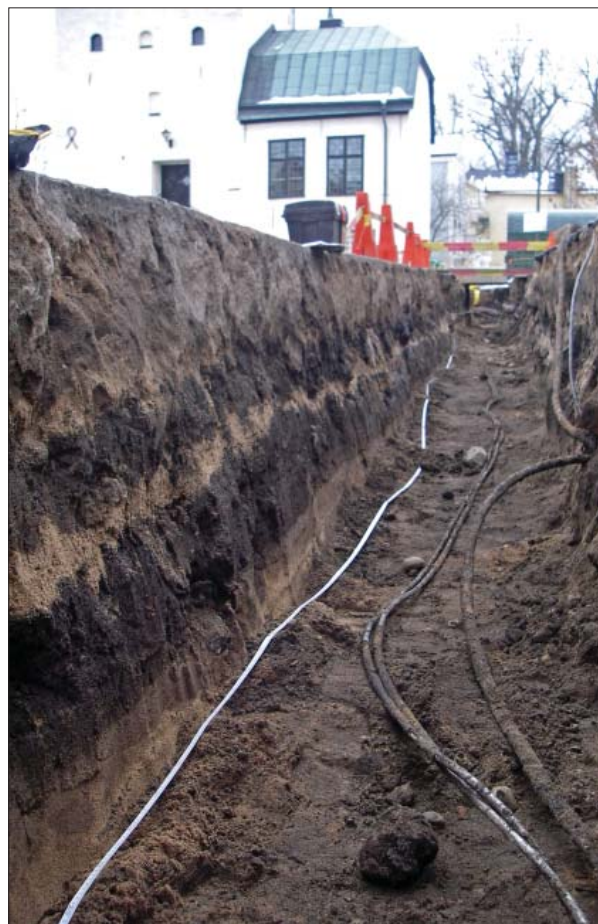
Figur 5. Delsträcka D under utgrävning. Foto mot SV, Ann-Charlott Feldt, ÖM.
