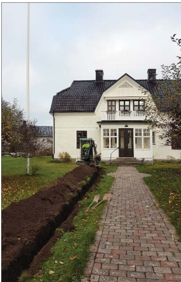
Figur 4. Det öppnade schaktet mellan Groggatan och boningshuset. Foto mot NNV, Emma Karlsson, ÖM.
