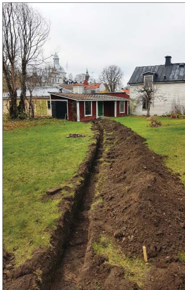
Figur 5. Det öppnade schaktet mellan boningshuset och en förrådsbyggnad i den norra delen av fastigheten. Foto mot NV, Emma Karlsson, ÖM.
