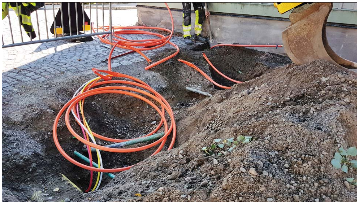
Figur 5. Schaktet strax intill Nybrogatan sett från nordväst. Under ledningarna och de sentida fyllnadsmassorna skyntar ett mörkare lager. Foto Ann-Charlott Feldt, ÖM.
