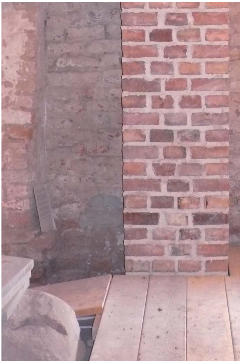
E 00 I LINKÖPINGS SLOTT LANDSHÖVDINGERESIDENSET Antikvarisk kontroll vid förstärkningsarbeten Innerstaden 1:13, Linköping 2010-03-22
