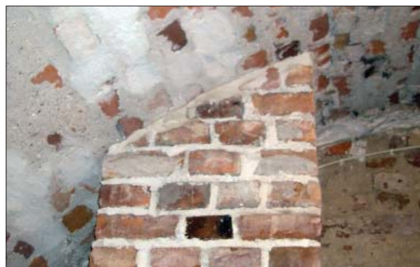
Figur 13. Kontreforens anslutning till valvet där det torrstoppsats med kalkbruk. Foto Ann-Charlott Feldt, ÖM.
