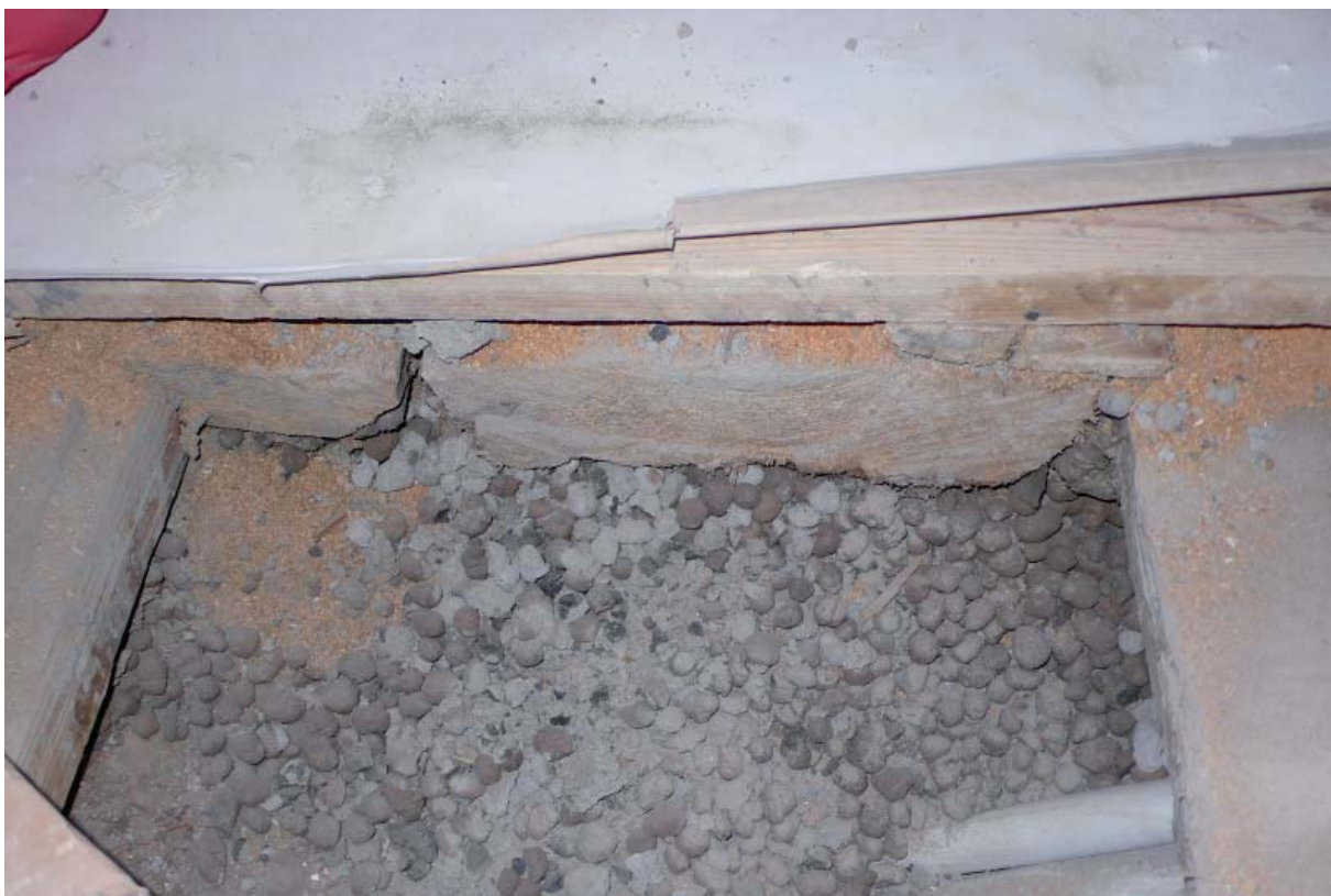
Bild 6. En äldre håltagning i det gamla golvet i plan 2, rum 250. Hålet taget för att dra upp vattenledningar till badrummen år 1981.
