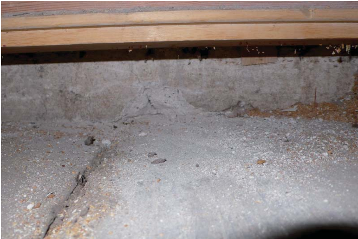
Bild 5. Närbild på det gamla trägolvet i plan 2, rum 250. Golvet försätter in under den sekundärt murade väggen.
