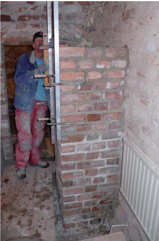
Bild 4. Pågående arbete med murning av kontreför i plan 1, rum 119.
