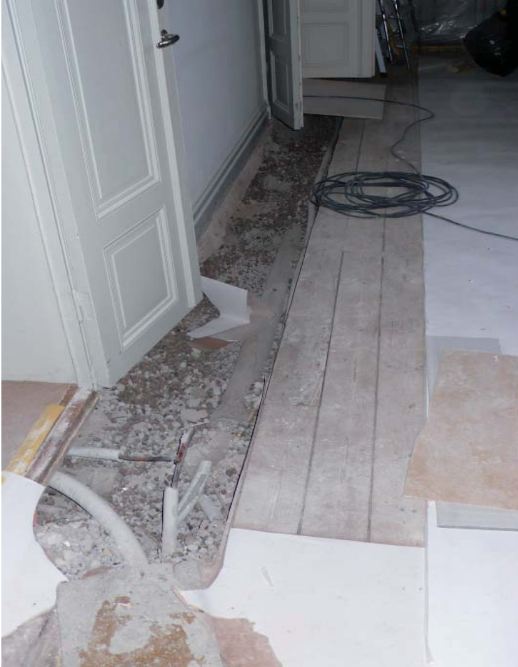
Bild 3. Den underminerade väggen i plan 2, rum 248 före åtgärd.
