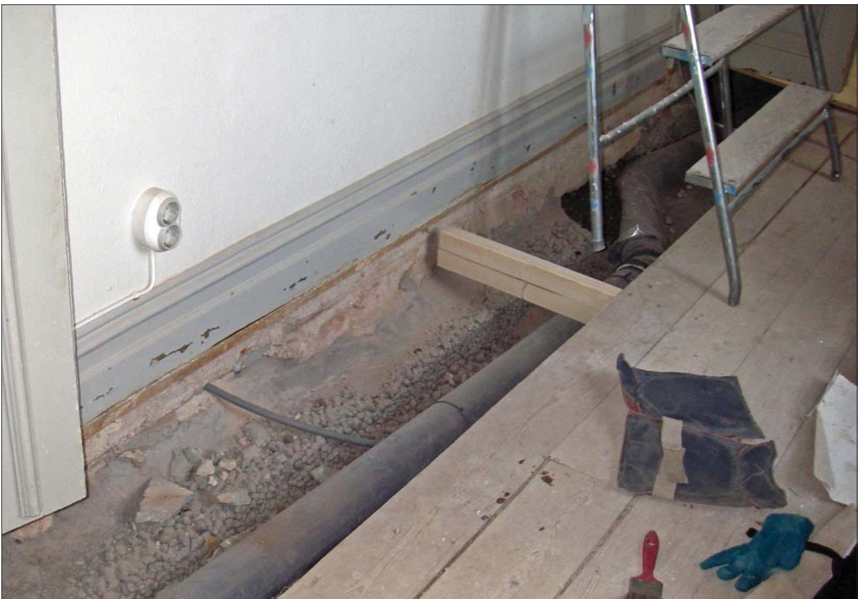
Figur 16. Schaktet i korridoren sett från sydöst. Foto Ann-Charlott Feldt, ÖM.
