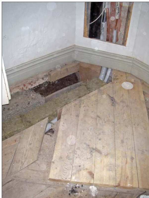
Figur 17. Schaktet i korridorens nordligaste del med öppning till den gamla rökgången. Foto Ann-Charlott Feldt, Ö
