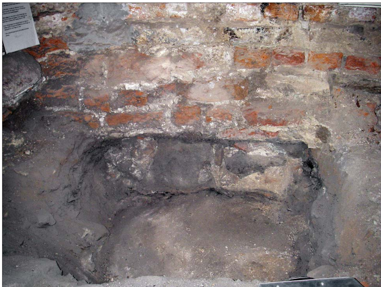
Figur 10. Kalkbruksytan fortsätter in under väggen. På bilden syns hur den norra väggen har ett tegelmurverk och under det ett gråstensmurverk som är förskjutet åt norr. Foto Ann-Charlott Feldt, ÖM.
