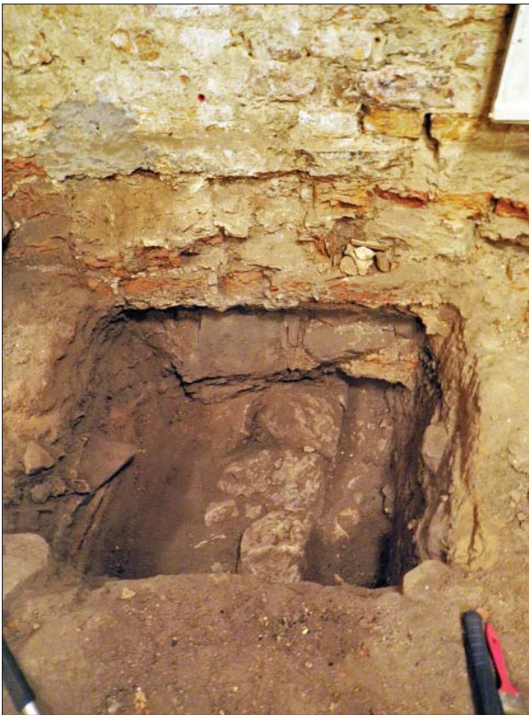
Figur 11. Muren under golvet i borgköket med norra väggen i bakgrunden. Foto Ann-Charlott Feldt, ÖM.
