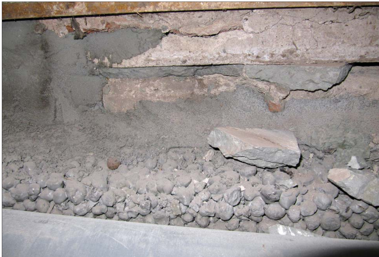
Figur 6. Schaktfyllning av lös Leca under korridorväggen en trappa upp i slottets västra länga. Foto Ann-Charlott Feldt, ÖM.
