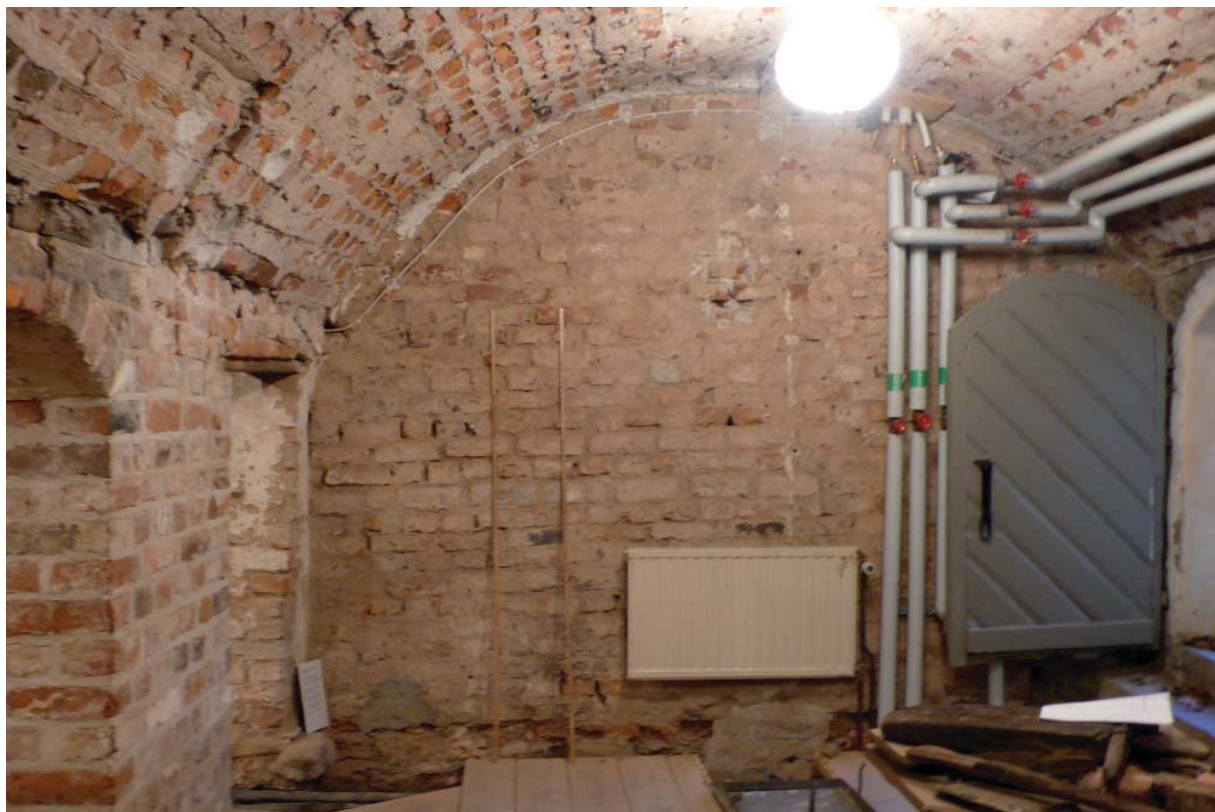
Bild 2. Rumme119 Borgköket före åtgärd. Tumstockar lutade mot väggen visar läget för den stödjande kontreforen.
