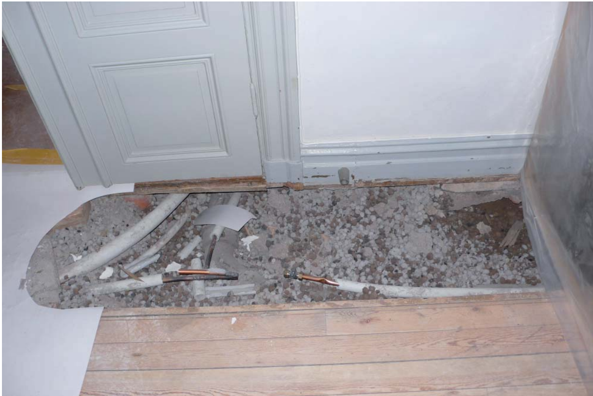
Bild 1. Den underminerade väggen i rum 248 med fyllning av lösa lecakulor.
