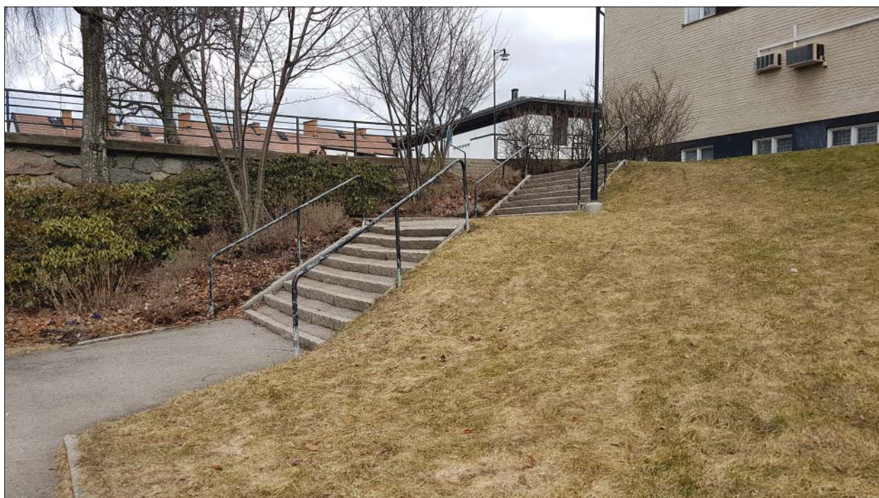
Figur 4. Den tidigare trappan som skulle ersättas med en ny, sedd från sydväst. Foto Ann-Charlott Feldt, ÖM.
