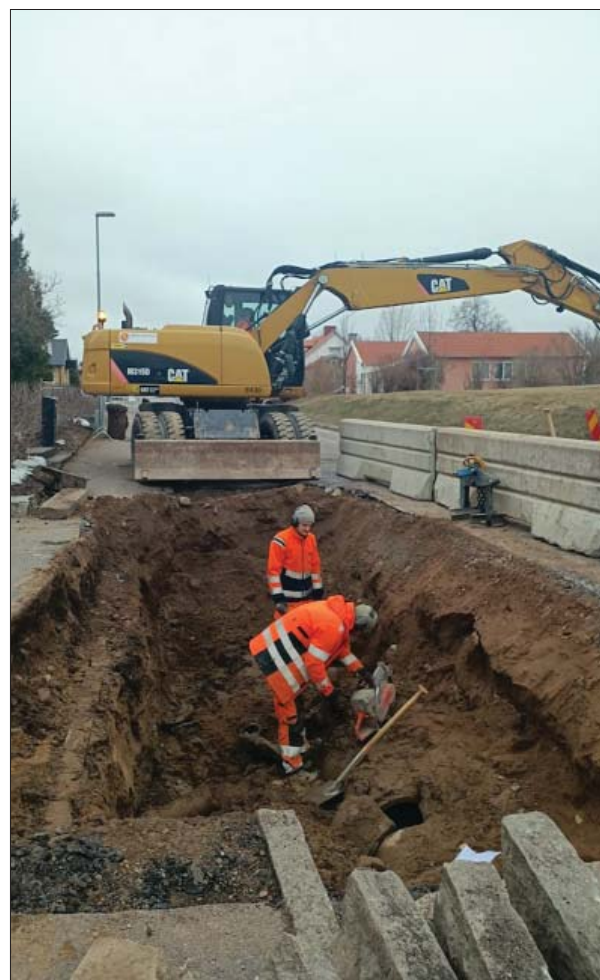
Figur 4. Schaktet innehöll endast moderna fyllnadsmassor med sand och grus. Foto från öster, Helén Romedahl, ÖM.
