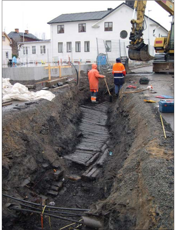
Figur 8. Träbroläggning i Hospitalsgatan. Foto från norr, Ann-Charlott Feldt, ÖM.
