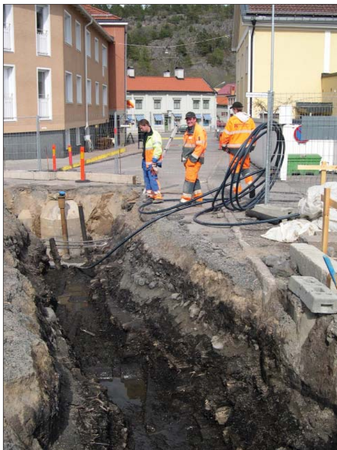
Figur 4. Schaktet i Hospitalsgatan, i korsningen mot Vintervadsgatan. Foto från söder, Ann-Charlott Feldt, ÖM.
