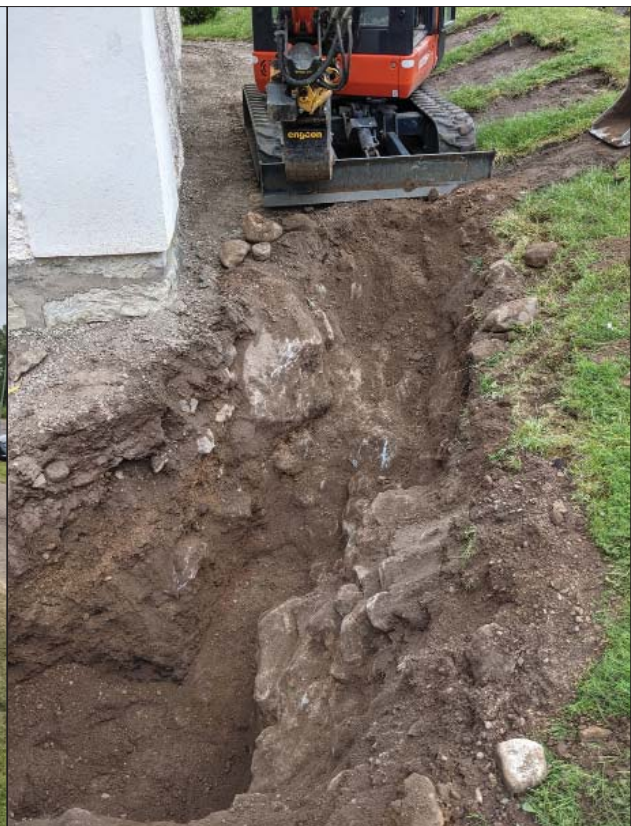
Figur 15 och 16. Där schaktet passerade koret framkom stenar sammanfogade med bruk vilket representerar den del av kyrkogårdsmuren som har raserats och vidgats, troligen för att ge plats när koret byggdes ut på 1500-talet. Foton mot N. Foto: Linnéa Hernqvist, ÖM.
