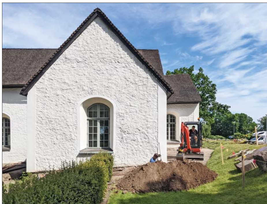
Figur 6. Schaktning runt gravkoret som byggdes till på 1600-talet. Bakom grävmaskinen skymtar koret, byggt på 1500-talet. Till höger syns tillfälligt flyttade gravvårdar. Foto mot N. Foto: Linnéa Hernqvist, ÖM.
