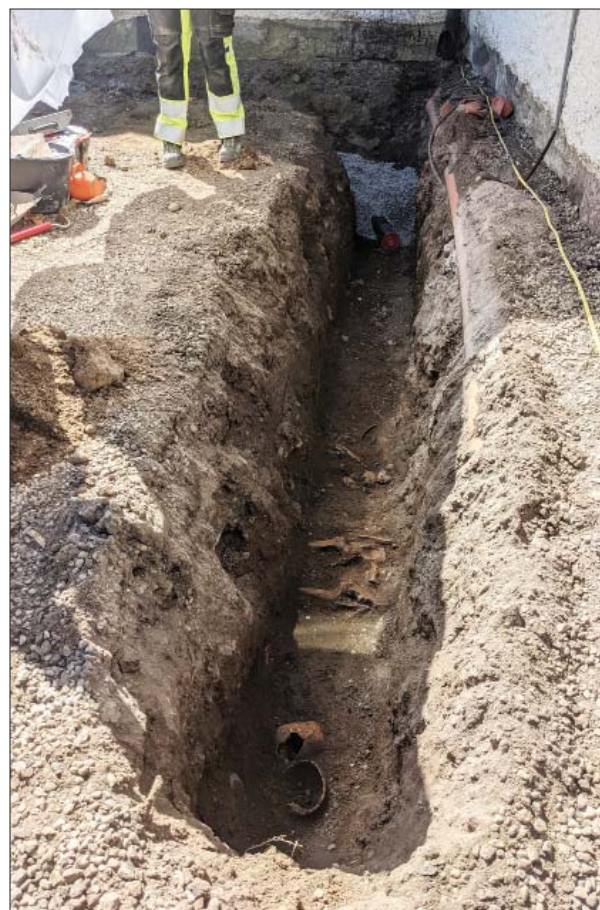
Figur 17. Grav 2, 3 och eventuella grav 4 samt ben från omrörda gravar. Grav 3, som består av lårben upp till nedersta ländkotan, ser ut att fortsätta under kyrkan och har sannolikt gravlagts före sakristian byggdes på 1300-talet. Foto mot S. Foto: Linnéa Hernqvist, ÖM.
