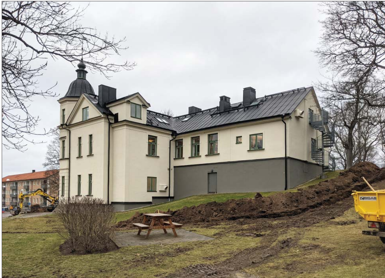
Figur 5. Södra schaktet. Foto mot NÖ, Linnéa Hernqvist, ÖM.
