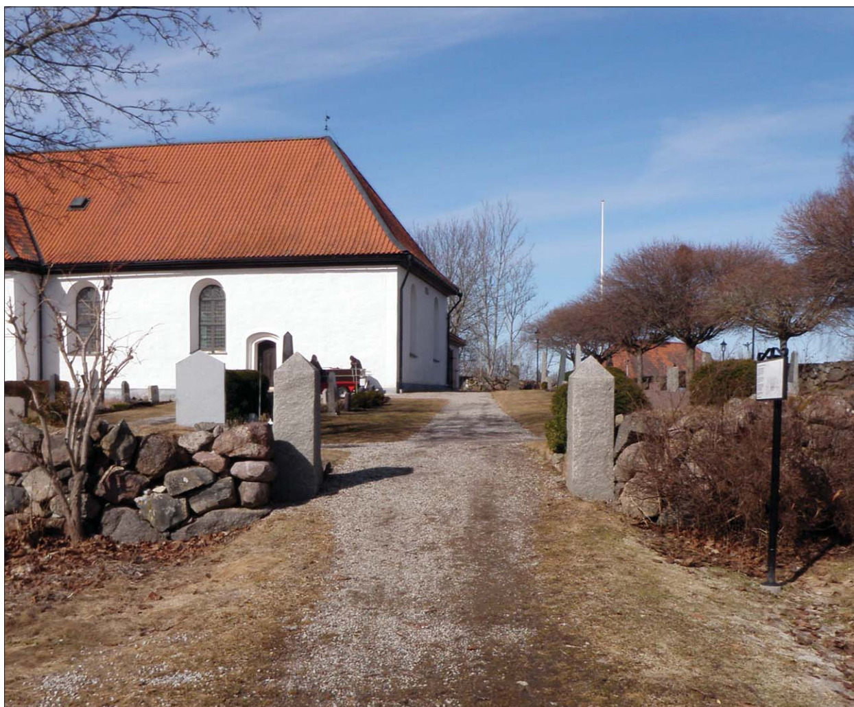
Figur 17. Genombrottet i muren 2011. Foto Olle Hörfors.
