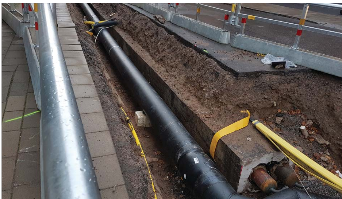
Figur 5. Den södra schaktväggen var störd av den gamla fjärrvärmekulverten som nu skulle ersättas av den nya ledningen. Schaktet sett från väster. Foto Ann-Charlott Feldt, Östergötlands museum.
