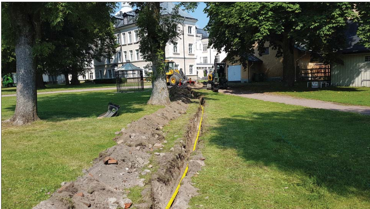
Figur 8. Schaktet i höjd med profil 2 sett från söder med uppgrävda raseringsmassor på schaktkanten. Foto Ann-Charlott Feldt, Östergötlands museum.
