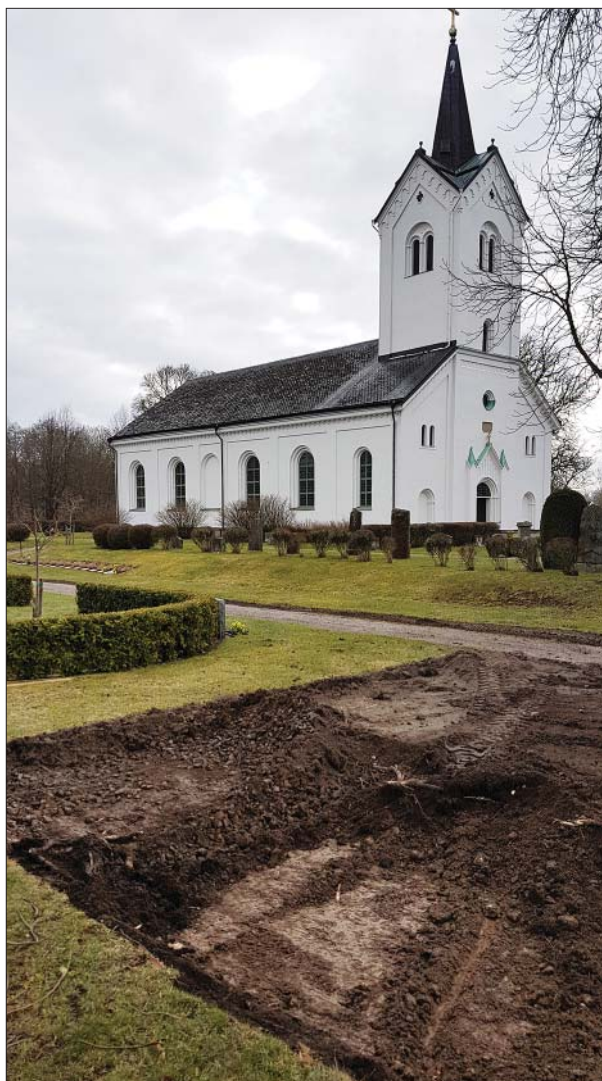
Figur 12. Schaktet för den västra byggnaden sett från nordväst. Foto Ann-Charlott Feldt, Östergötlands museum.
