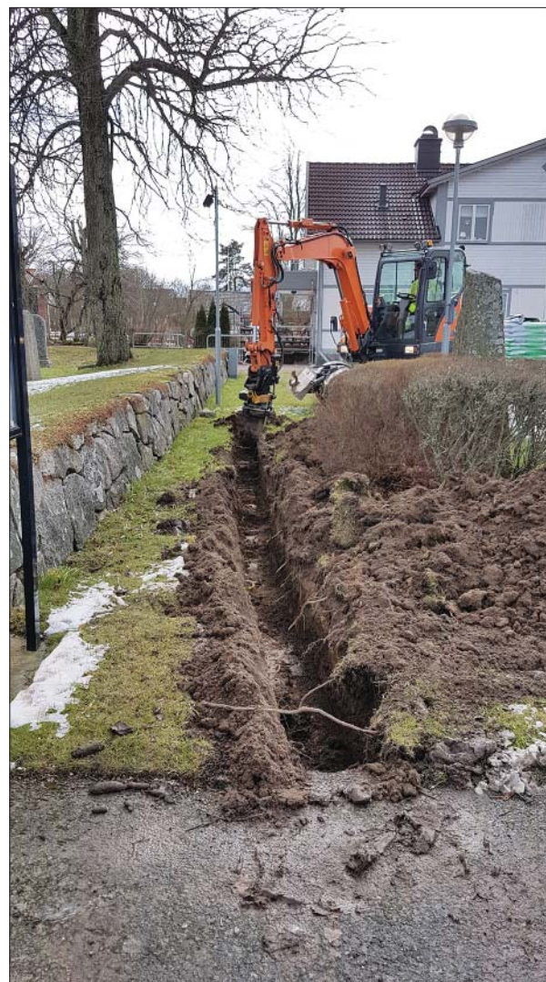
Figur 11. Kabelschaktet längs västra bogårdsmuren sett från norr. Foto Ann-Charlott Feldt, Östergötlands museum.
