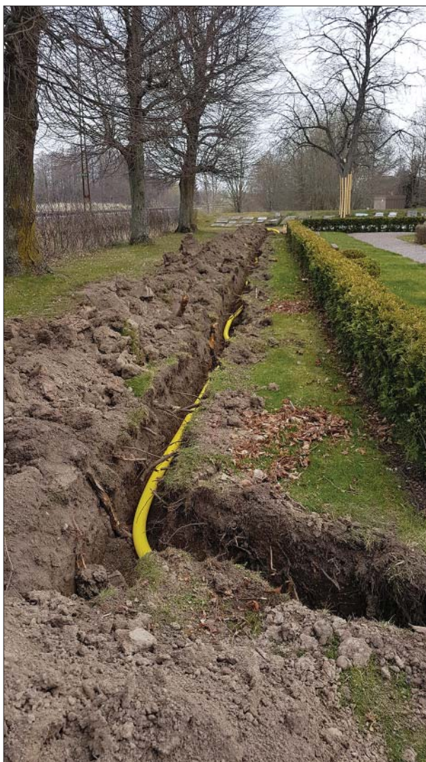
Figur 10. Kabelschaktet från den östra byggnaden sett från väster. Foto Ann-Charlott Feldt, Östergötlands museum.
