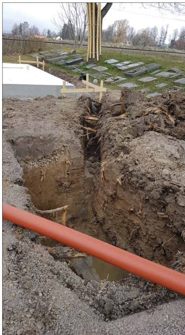
Figur 9. Schaktet för stenkistan vid den östra byggnaden sett från söder. Foto Ann-Charlott Feldt, Östergötlands museum.
