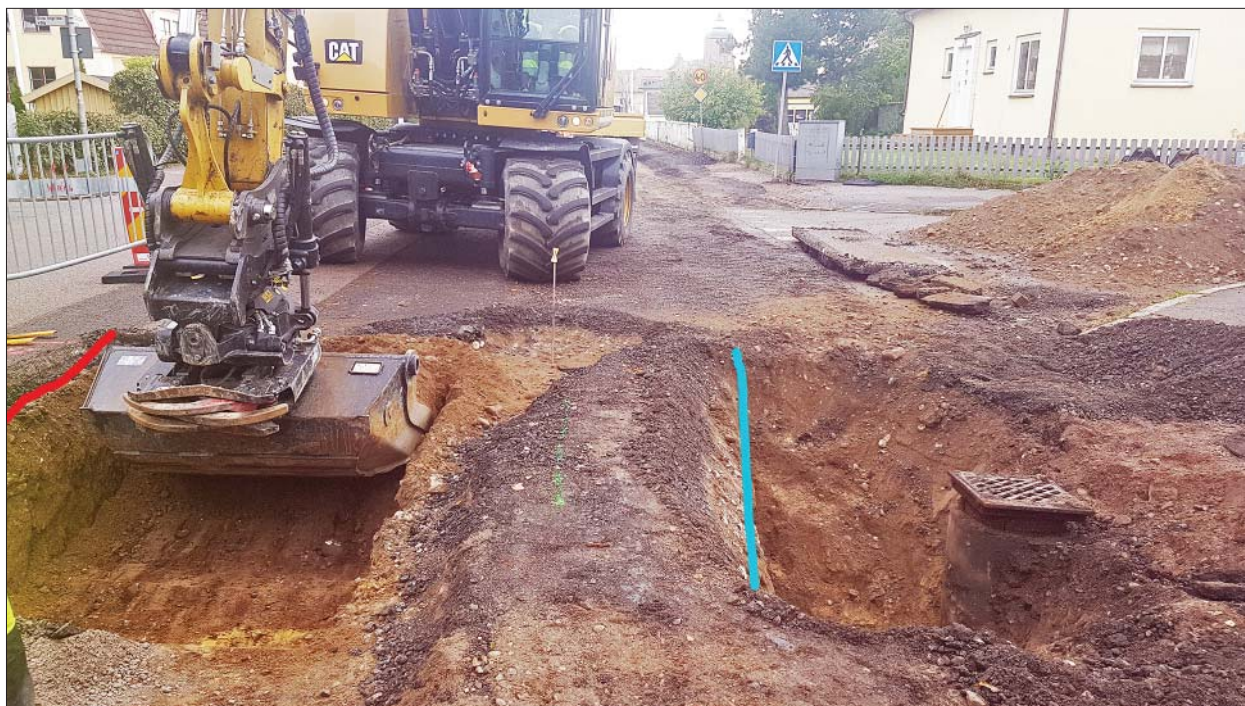
Figur 8. Schakt 25. Upptagning av schaktet i korsningen Vadstenagatan/Ture Långgatan. Blå respektive röd linje markerar läget för sektion 1A respektive 1B. Foto från väster, Helén Romedahl, ÖM.
