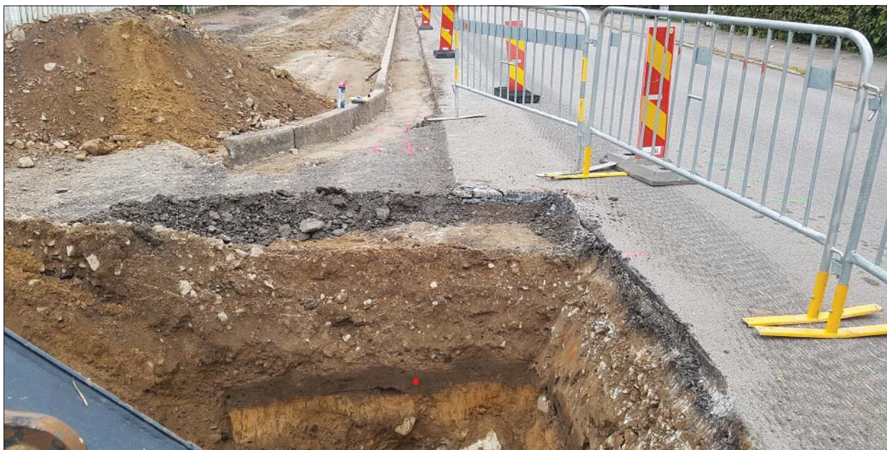
Figur 7. Schakt 810. Bevarat kulturlager i den västra sektionen. Röd punkt markerar det lager från vilket ett djurben med hjälp av ^{14}\text{C} -analys kunde dateras till 1200-talet. Foto från öster, Helén Romedahl, ÖM.
