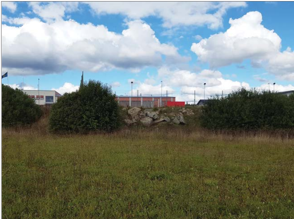
Den uppbyggda terrasseringen för fotbollsplanen i NV delen av området, från S. Foto Anders Olofsson, ÖM.
