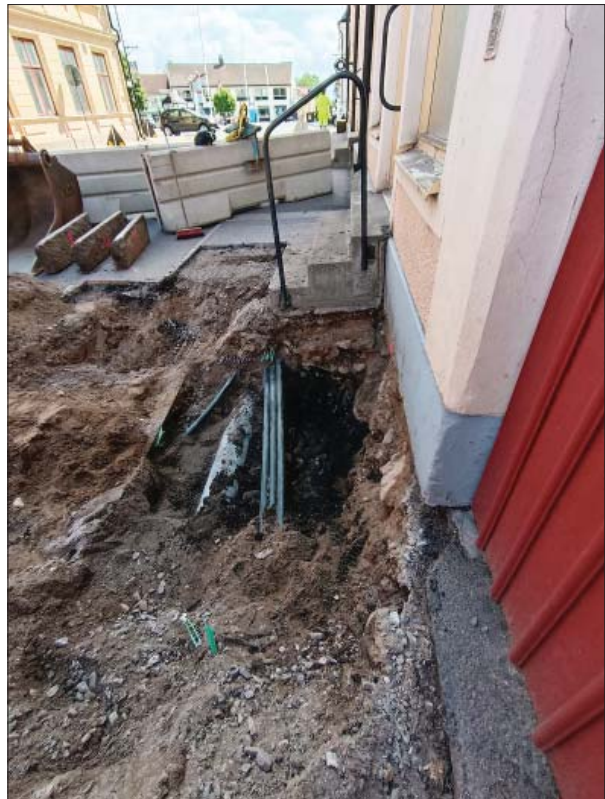
Figur 7. Schaktet var genombrutet av flera ledningar. Foto från väster, Helén Romedahl, ÖM.
