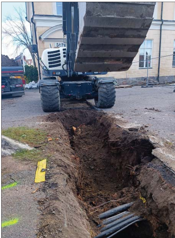
Figur 8. Schaktet togs upp skolgården hörande till S:t Persskolan. Foto från nordväst, Helén Romedahl, ÖM.
