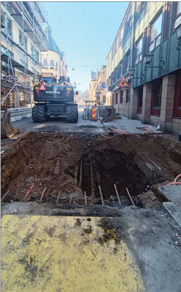
Figur 6. Schaktet var genombrutet av ett flertal ledningar. Foto från öster, Helén Romedahl, ÖM.
