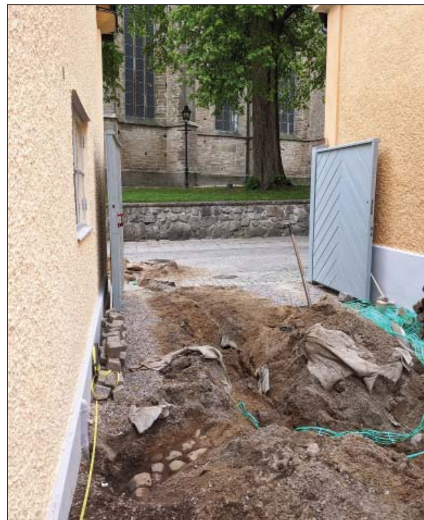
Figur 5. Kabelschaktet där det passerade genom porten från Ågatan in på tomtmark i kv Aposteln 3. I förgrunden syns kullerstensläggningen. Foto mot söder med domkyrkan i bakgrunden. Foto: Linnéa Hernqvist, ÖM.
