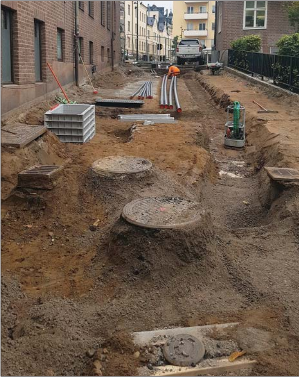
Figur 13. Ledningsdragnings i gränden. Foto från norr, Helén Romedahl, ÖM.
