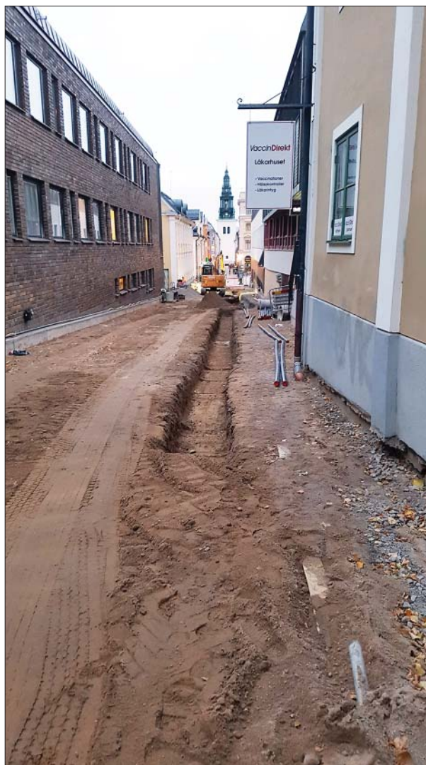
Figur 11. Schaktet i Domkyrkogatan. Längst bort i bilden syns Stora torget och S:t Larskyrkan. Foto från väster, Helén Romedahl, ÖM.
