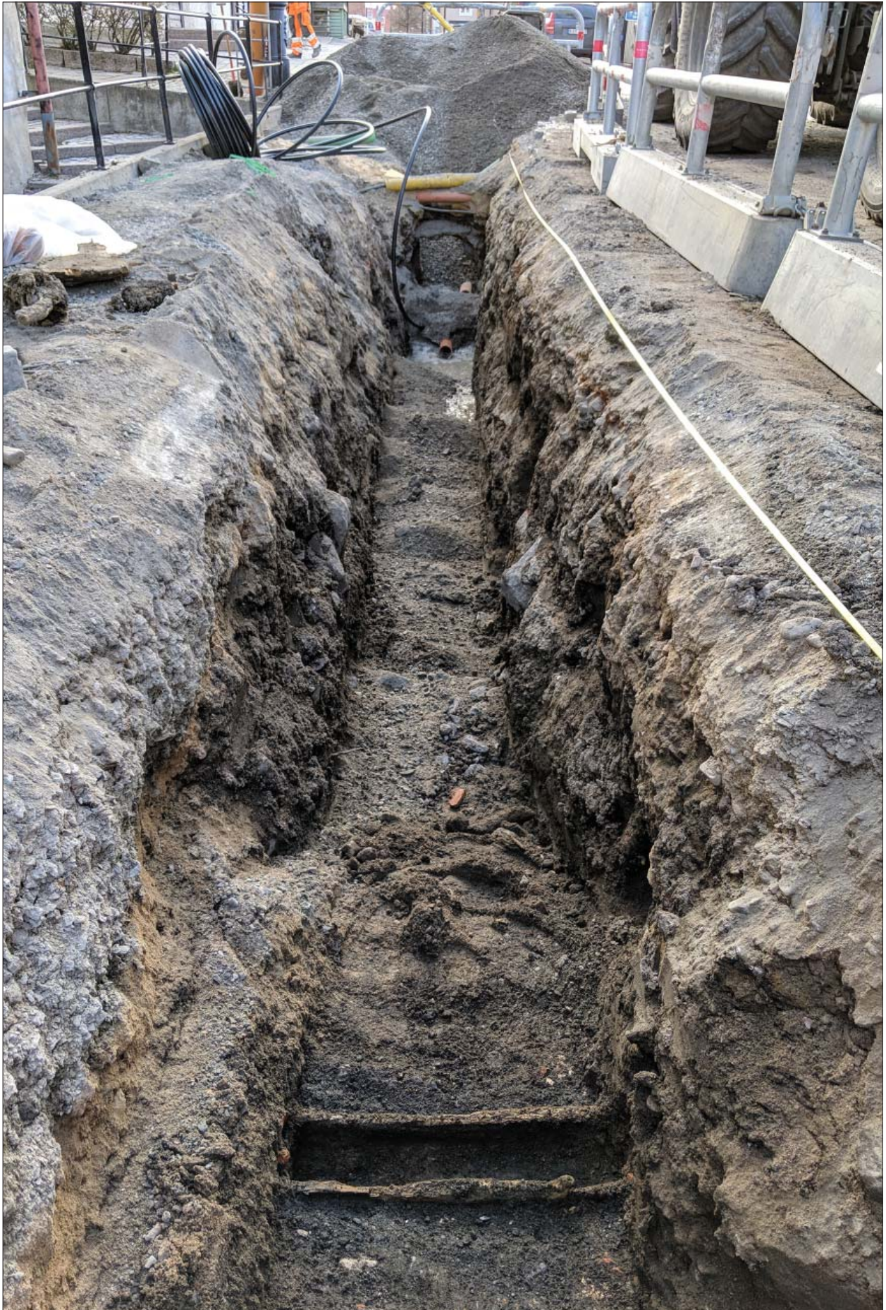
Figur 13. Dräneringsrännna 2 av trä, vid 9,4 m och ca 1,45 m under marknivå. Foto från väst, Mats Magnusson, ÖM.
