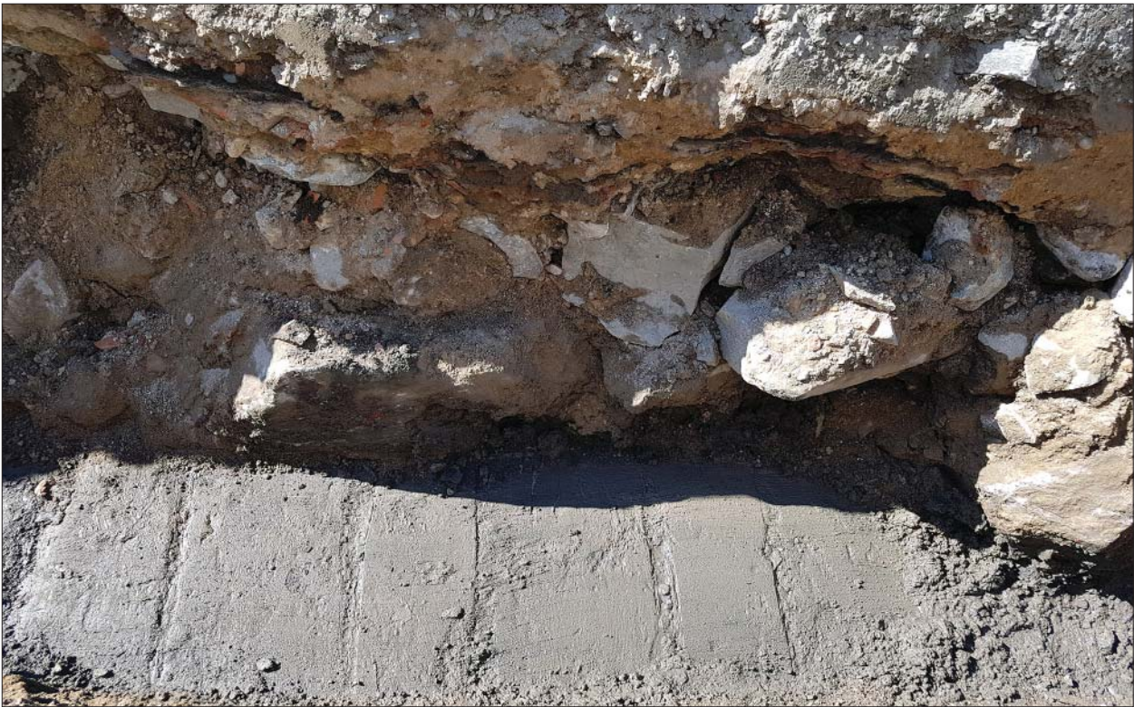
Figur 7. Rustbädd som utgjort stöd för en kraftig grundmur. Foto från norr, Helén Romedahl, ÖM.
