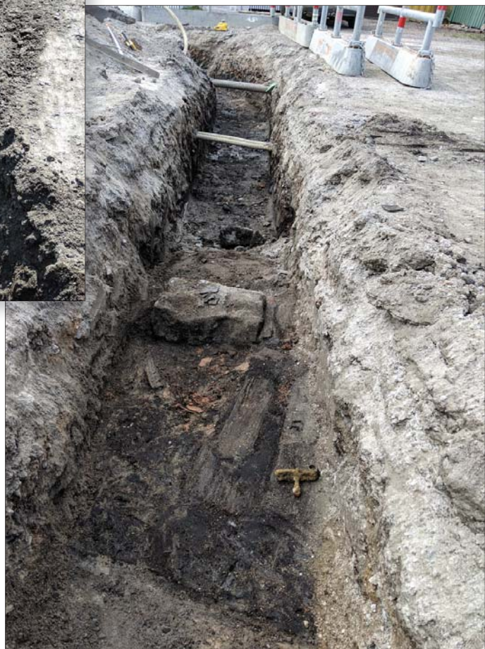
Figur 15. En kollapsad trädörr till en raserad byggnad. Foto från NÖ, Mats Magnusson, ÖM.
