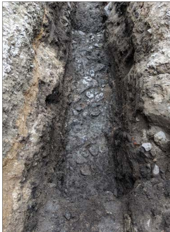
Figur 6. Stenläggning på 1,5 m under dagens asfalt. Foto från öster, Mats Magnusson, ÖM.
