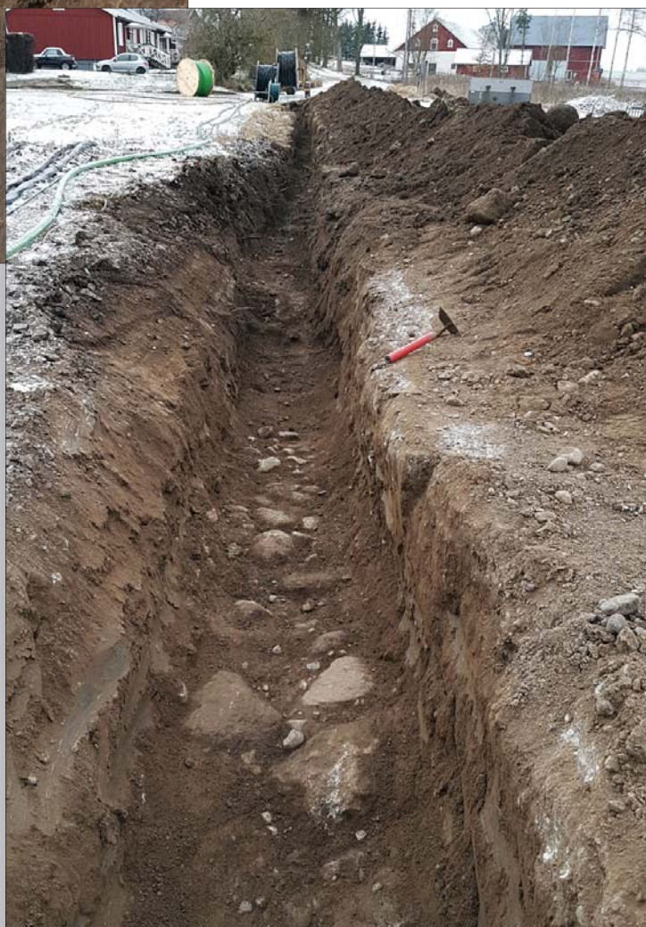
Figur 27. I schaktbotten inom sträcka 5 framkom en stenlagd vägsträckning som utifrån kartmaterialet dateras till 1800-tal (A1841). Foto mot NV, Per Nilsson, ÖM.
