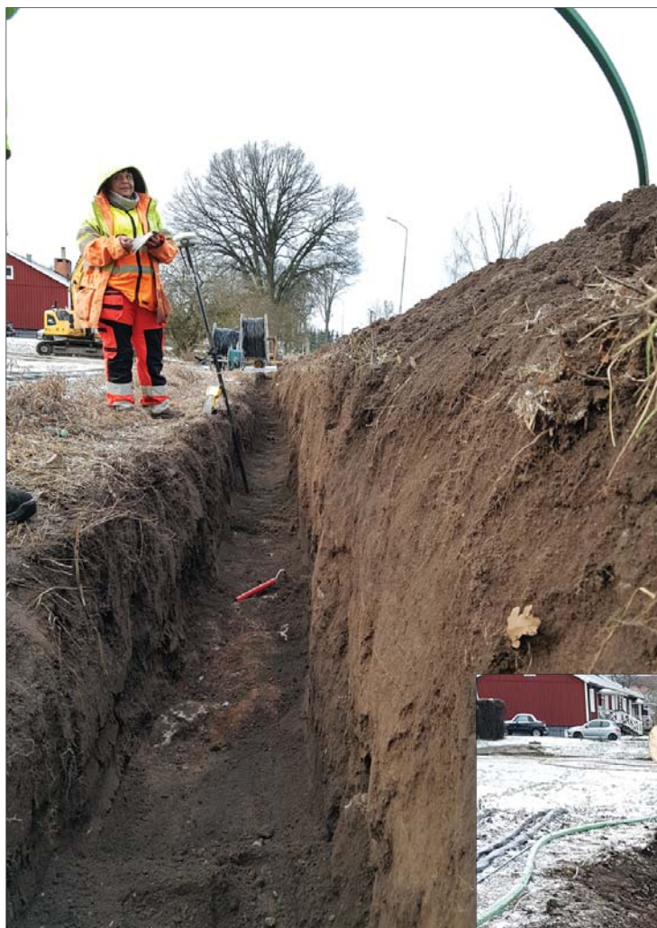
Figur 26. I schaktbotten inom sträcka 5 dokumenterades ett spisfundament av kalksten och bränd lera (A1914). Foto mot NV, Per Nilsson, ÖM.
