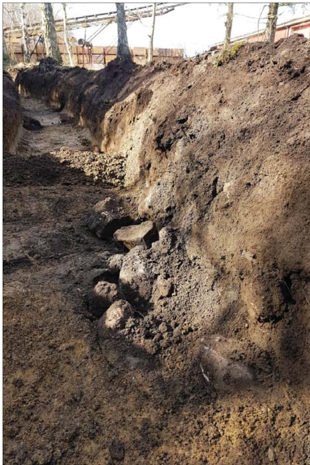
Figur 14. Stenfylld nedgrävning A939. Jmf profil. Foto mot V, Emma Karlsson, ÖM.
