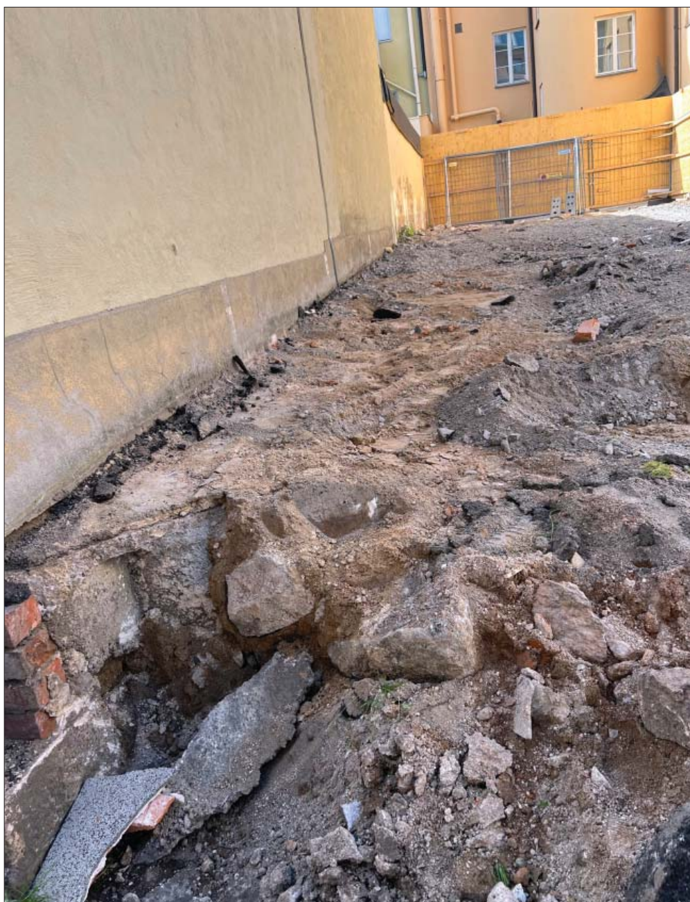
Figur 8. Markytan med asfalt och bärlager för asfalt borttaget. Foto mot söder. Vasaparkens Fastighets AB.
