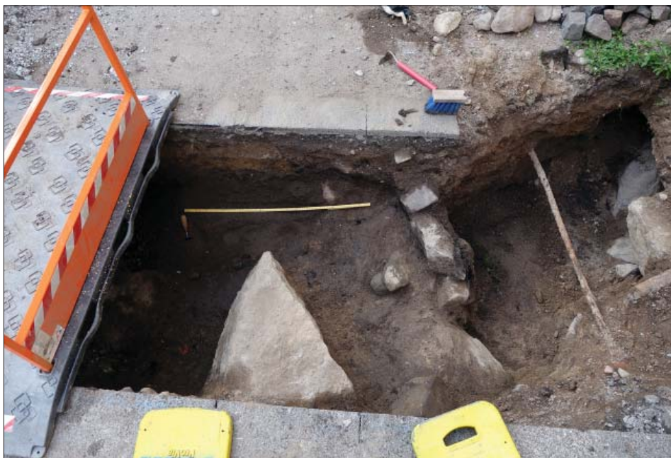
Figur 4. Västra delen av schaktet på för ledningen erforderat djup. Foto mot söder, Roger Lundgren, ÖM.
