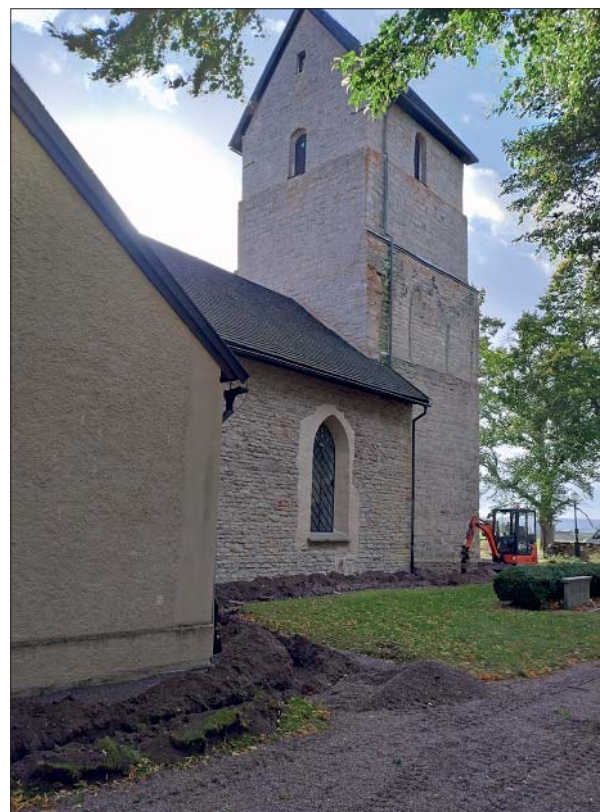
Figur 9. Den västra delen av schakt 3 på kyrkogården sett från nordöst. Foto Ann-Charlott Feldt, Östergötlands museum.
