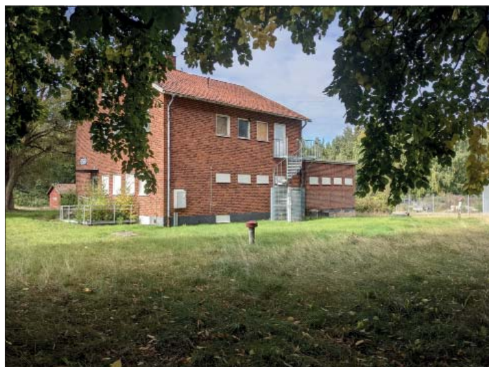
Figur 12. Skänninge gamla vattenverk i fastighet Fällinge 26:17/26:18. Foto mot NV: Linnéa Hernqvist, ÖM.
