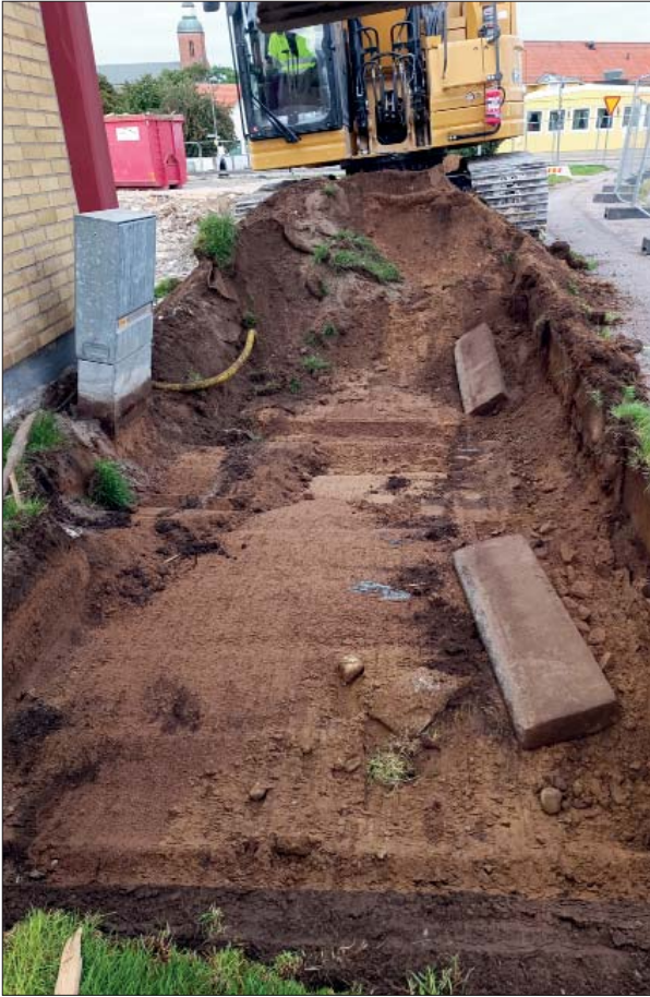
Figur 7. Schaktet vid elskåpet innehöll endast recenta fyllnadsmassor. Foto från söder, Helén Romedahl, ÖM.
