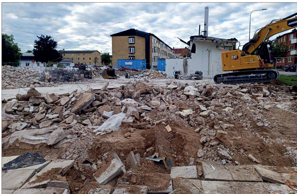
Figur 5. Rivning av den gamla Konsumbutiken på Holmen. Foto från norr, Helén Romedahl, ÖM.
