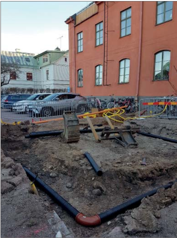
Figur 5a. Översiktsfoto över Schakt 1. Mot nordost. Foto Emma Karlsson, ÖM.
