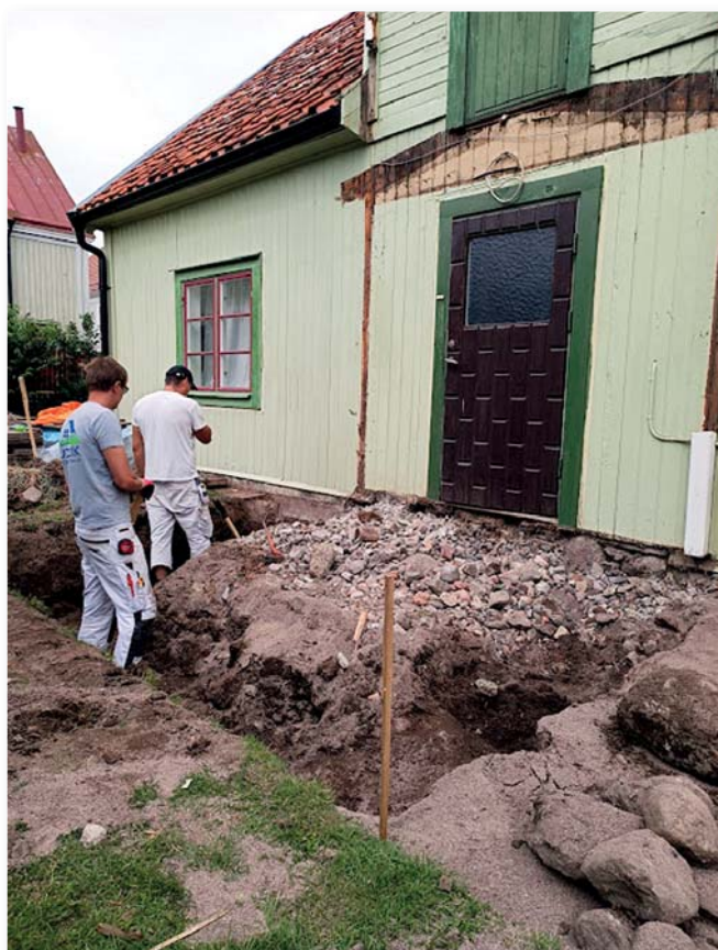
Figur 7. Schaktet delvis grävt. Foto från söder, Helén Romedahl, ÖM.
