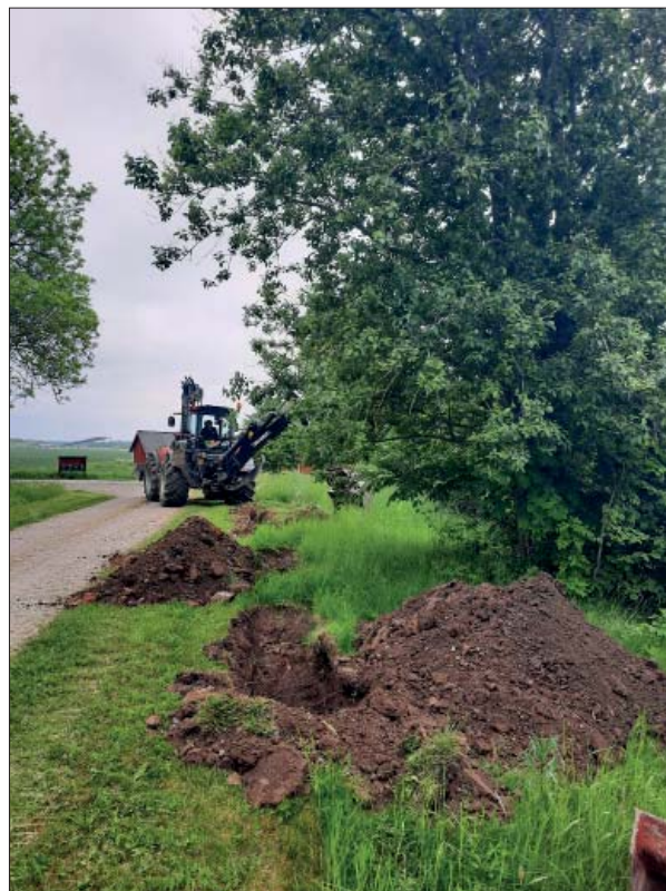
Figur 11 (t h). Schaktning vid infartsvägen mot Frössle gård. Foto mot öster, Per Nilsson.
