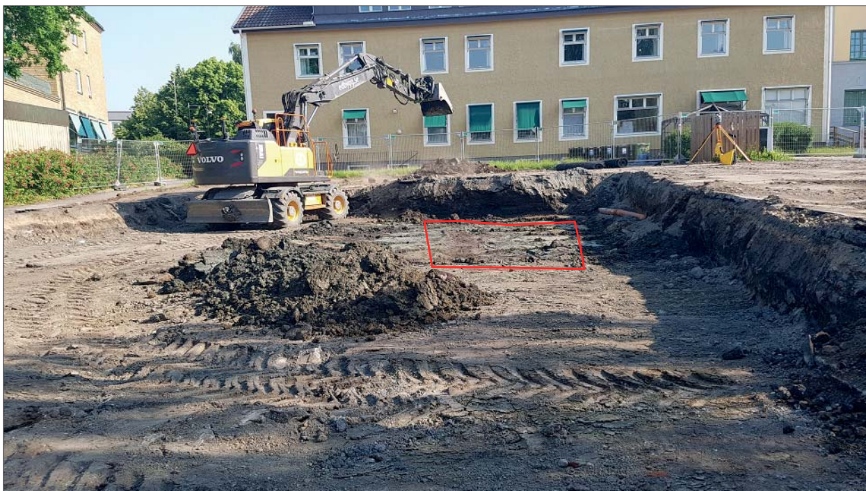
Figur 6. Ytan som hade schaktats ner till den orörda undergrunden utan exploatören hade meddelat ansvarig arkeolog om att arbetet hade inletts. Röd rektangel markerar ungefärligt läge för den träkonstruktion som låg i bottenleran. Foto från söder, Helén Romedahl, ÖM.
