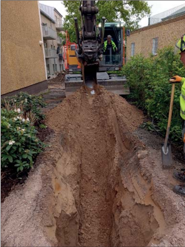
Figur 9. Schaktetapp som var störd och återfylld med mycket lucker sand. Foto mot söder, Helén Romedahl, ÖM.
