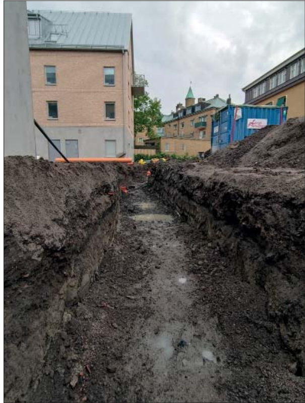
Figur 10. Sektion 4034 till höger i bild och sektion 4036 till vänster. Foto mot väster, Helén Romedahl, ÖM.
