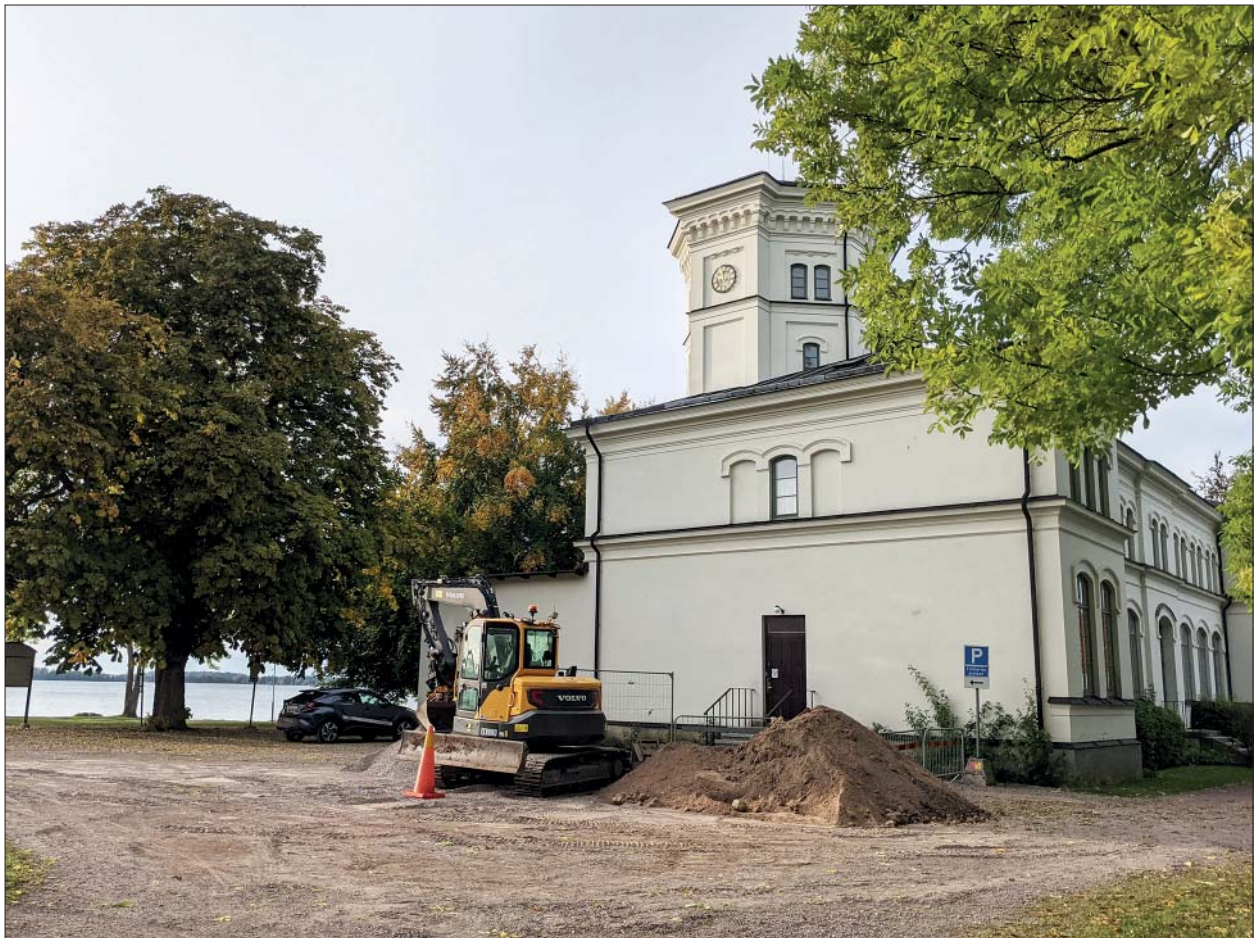
Figur 12. Undersökningsområdet sett från sydöst. Tornhuset byggdes på 1860-talet. Foto: Linnéa Hernqvist, ÖM.
