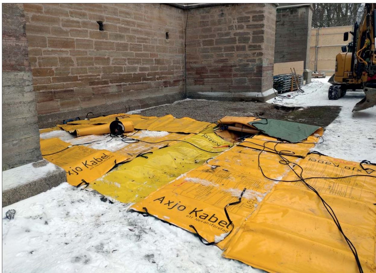
Figur 7. Tjälen i marken tinades med elektriska värmemattor som här på kyrkans norra sida. Foto Ann-Charlott Feldt, Östergötlands museum.
