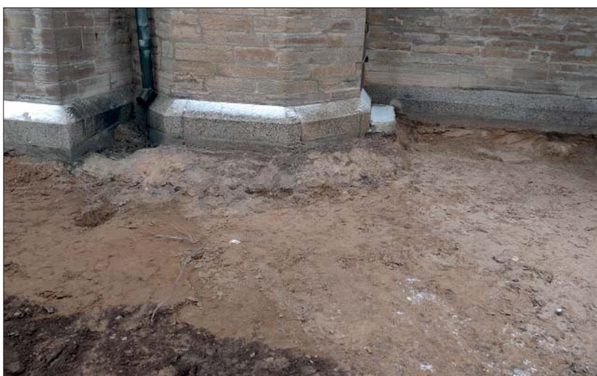
Figur 11. Övre delen av grundläggningen till trapptornet på domkyrkans södra sida sedd söder. Foto Ann-Charlott Feldt, Östergötlands museum.
