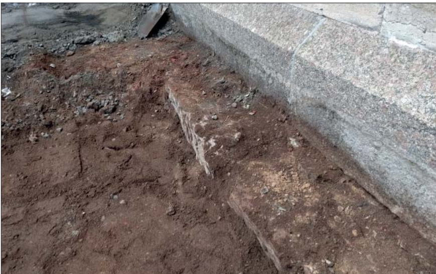
Figur 16. Grundläggningen på norra sidan bestod delvis av kvaderhuggen sten med ett gulaktigt kalkbruk på ytan. Foto från väster, Ann-Charlott Feldt, Östergötlands museum.
