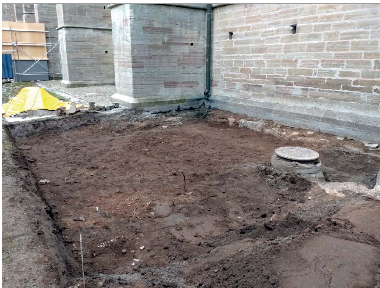
Figur 14. Schaktet på norra sidan sett från väster. Runt strävpelaren på schaktets östra sida syns hur grundläggningen sträcker sig långt utanför pelaren. Foto Ann-Charlott Feldt, Östergötlands museum.
