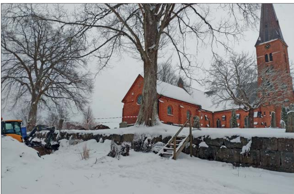
Figur 12. Schaktning norr om den norra kyrkogårdsmuren sedd från nordväst. Foto Ann-Charlott Feldt, Östergötlands museum.
