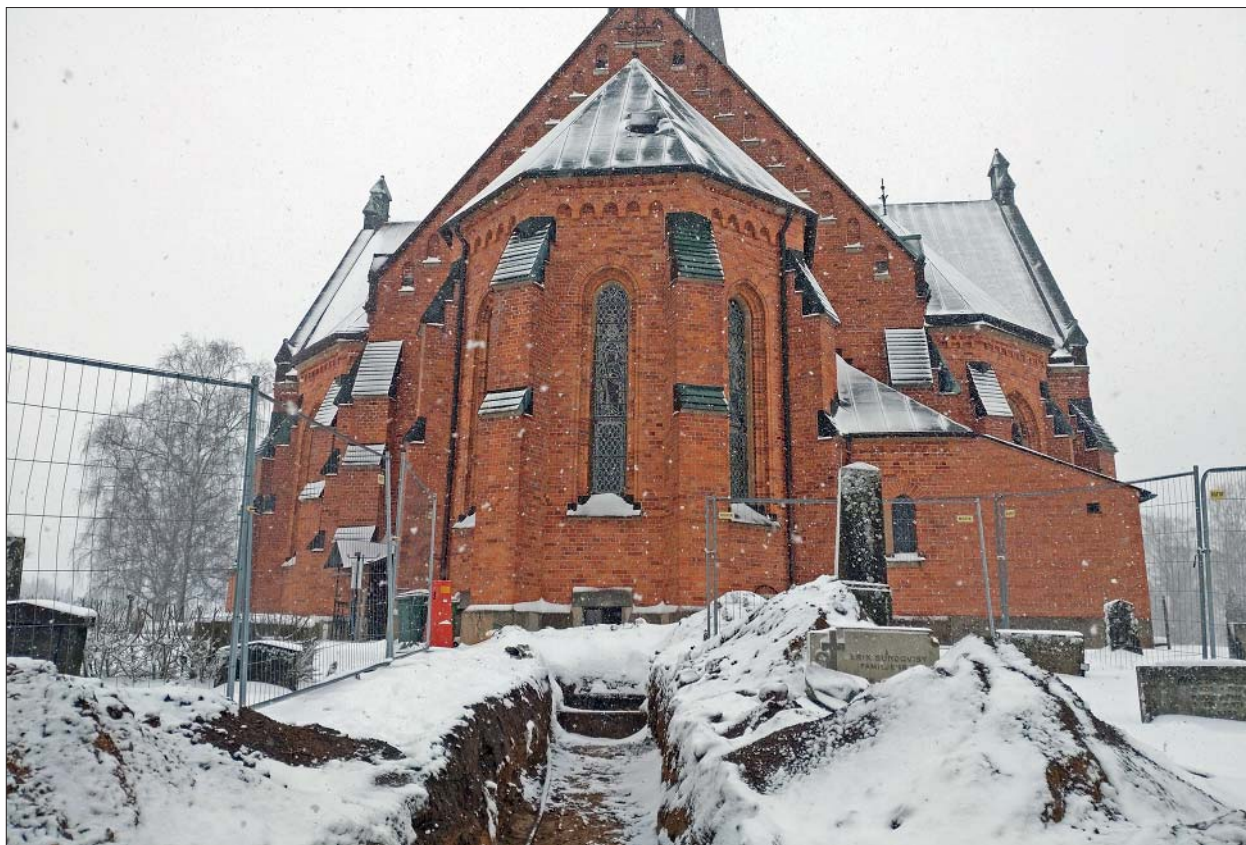
Figur 6. Schaktet närmast kyrkans kor sett från öster. I änden på schaktet finns väggen till det underjordiska källarutrymmet. Foto Ann-Charlott Feldt, Östergötlands museum.
