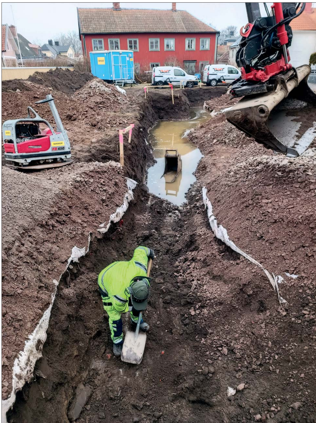
Figur 8. Schaktningarna i tomtmark berörde det medeltida försvarsverkets fyllnadslager. Den tidigare undersökta delen av diket var nu vattenfylld. Foto från öster, Helén Romedahl, ÖM.
