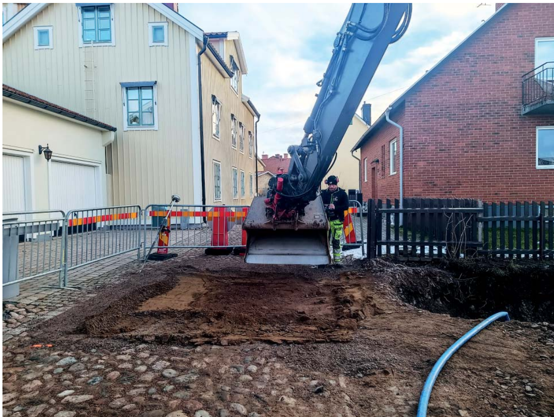
Figur 10. Schaktet i Gropgatan. Foto från väster, Helén Romedahl, ÖM.
