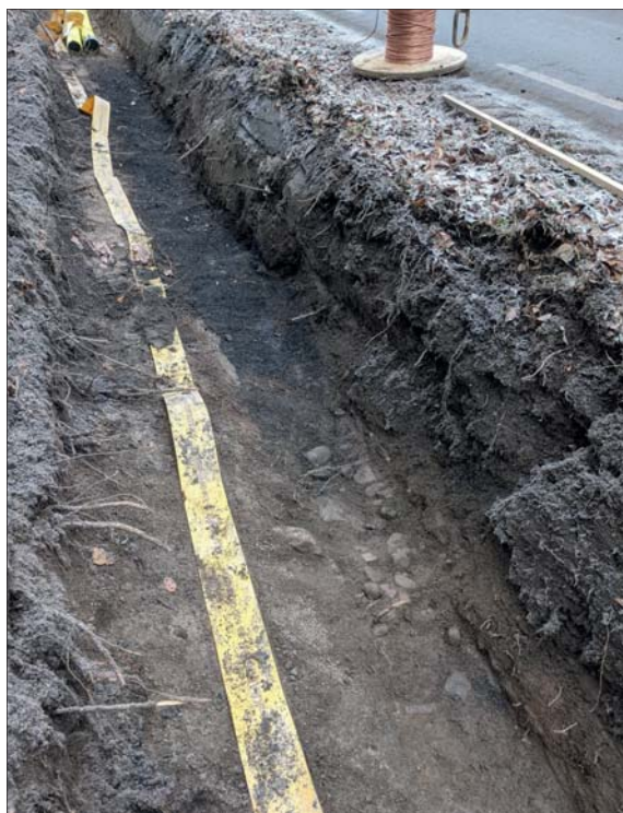
Figur 16. Lämningarna framkom i schaktbotten och kunde lämnas kvar orörda. Troligen fortsätter kullerstensläggningen under kol- och sotlagret. Gula kabelbandet markerar gammalt elkabelschakt. Foto: Linnéa Hernqvist, ÖM, mot N.
