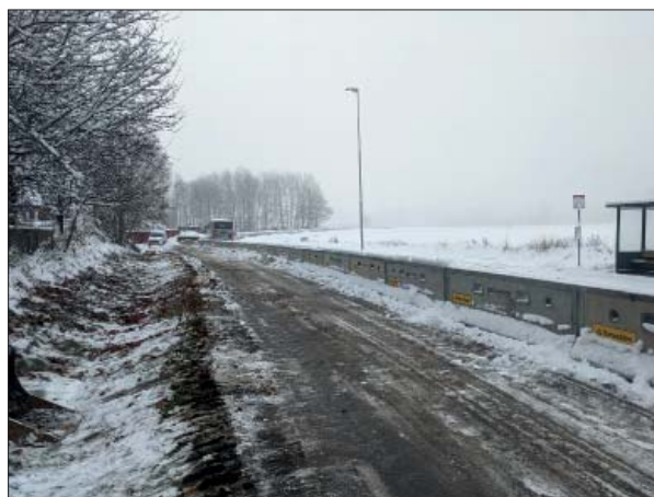
Figur 8. Före schaktning påbörjades i den södra delen av sträcka 2. Foto: Linnéa Hernqvist, ÖM, mot SÖ.
