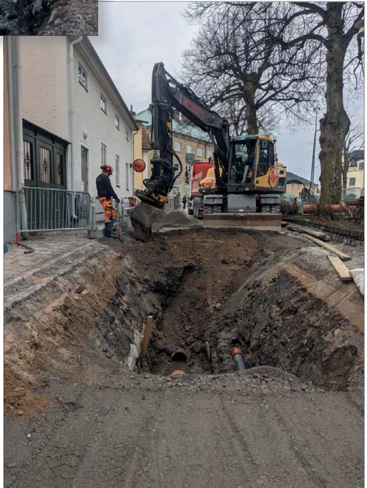
Figur 7. I schaktväggarna syntes enbart återfyllda kulturlager och därovan sand. Foto från nordväst, Linnéa Hernqvist, ÖM.
