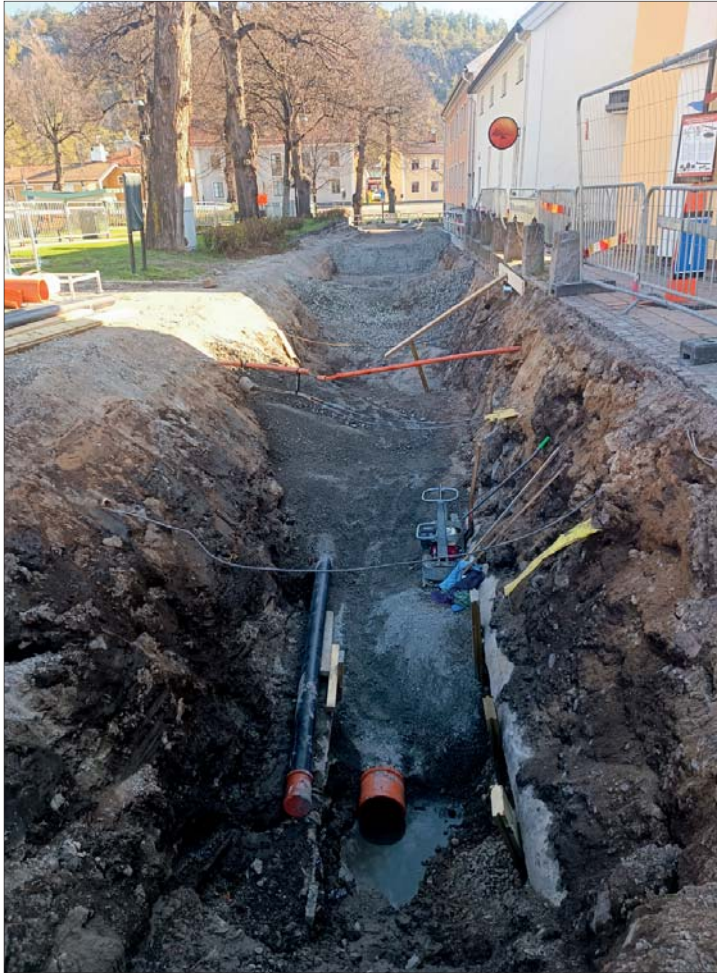
Figur 6. Exempel på ledningsdragningar i Östra Hagagatan. Återfyllda kulturlager syns i schaktsektionerna. Foto från sydväst, Helén Romedahl, ÖM.
