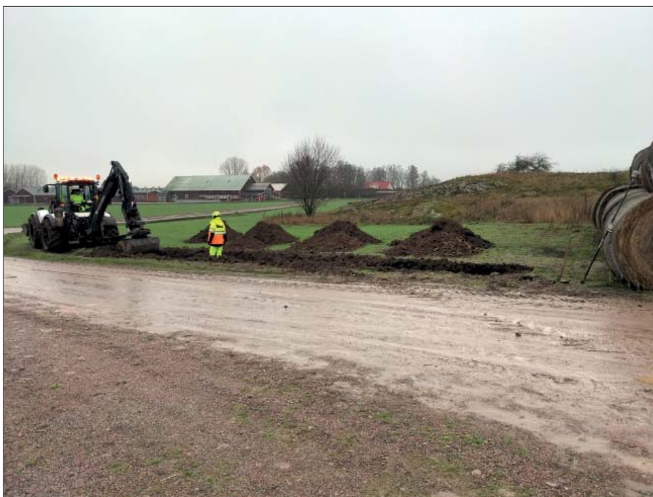
Figur 11. Schaktning vid UO5. Foto mot V, Roger Lundgren, ÖM.
