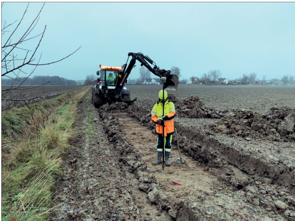
Figur 7. Schaktning vid UO2. Foto mot V, Roger Lundgren, ÖM.
