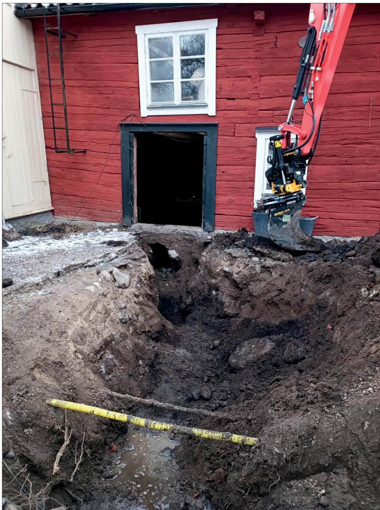
Figur 13. Schaktet för VA-ledning. I bakgrunden syns Mangelboden. Foto mot väster, Helén Romedahl, ÖM.
