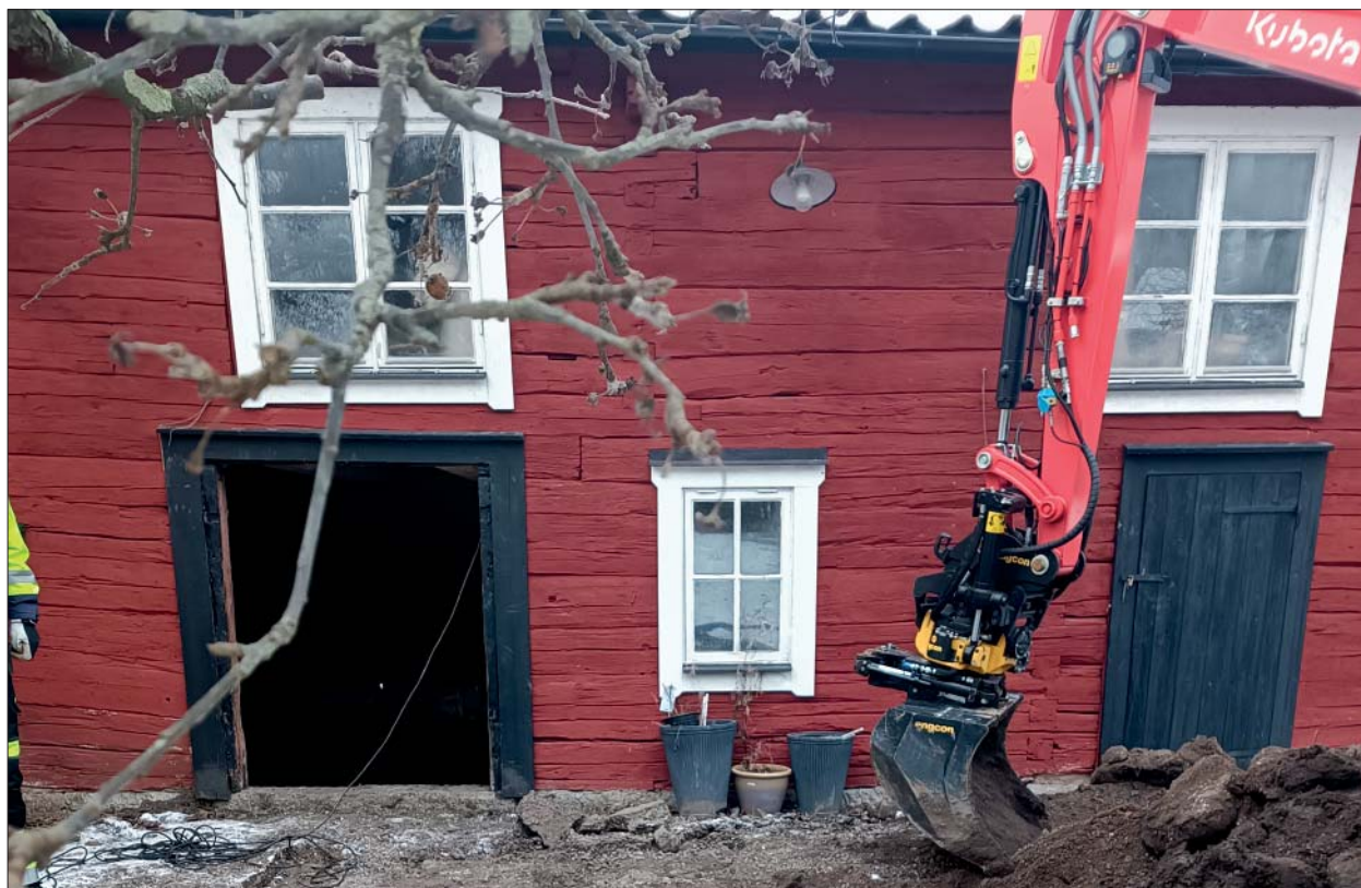
Figur 6. Mangelboden. Foto mot väster, Helén Romedahl, ÖM.
