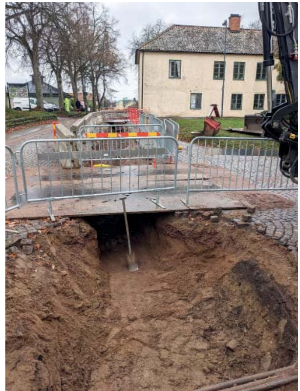
Figur 16. Schaktsträckan i Klostergatan var utschaktad, förutom en liten del av den östra änden av schaktet, i korsningen Klostergatan/Kyrkogatan (nederst till höger i bild syns kulturlager). Foto mot V, Linnéa Hernqvist, ÖM.
