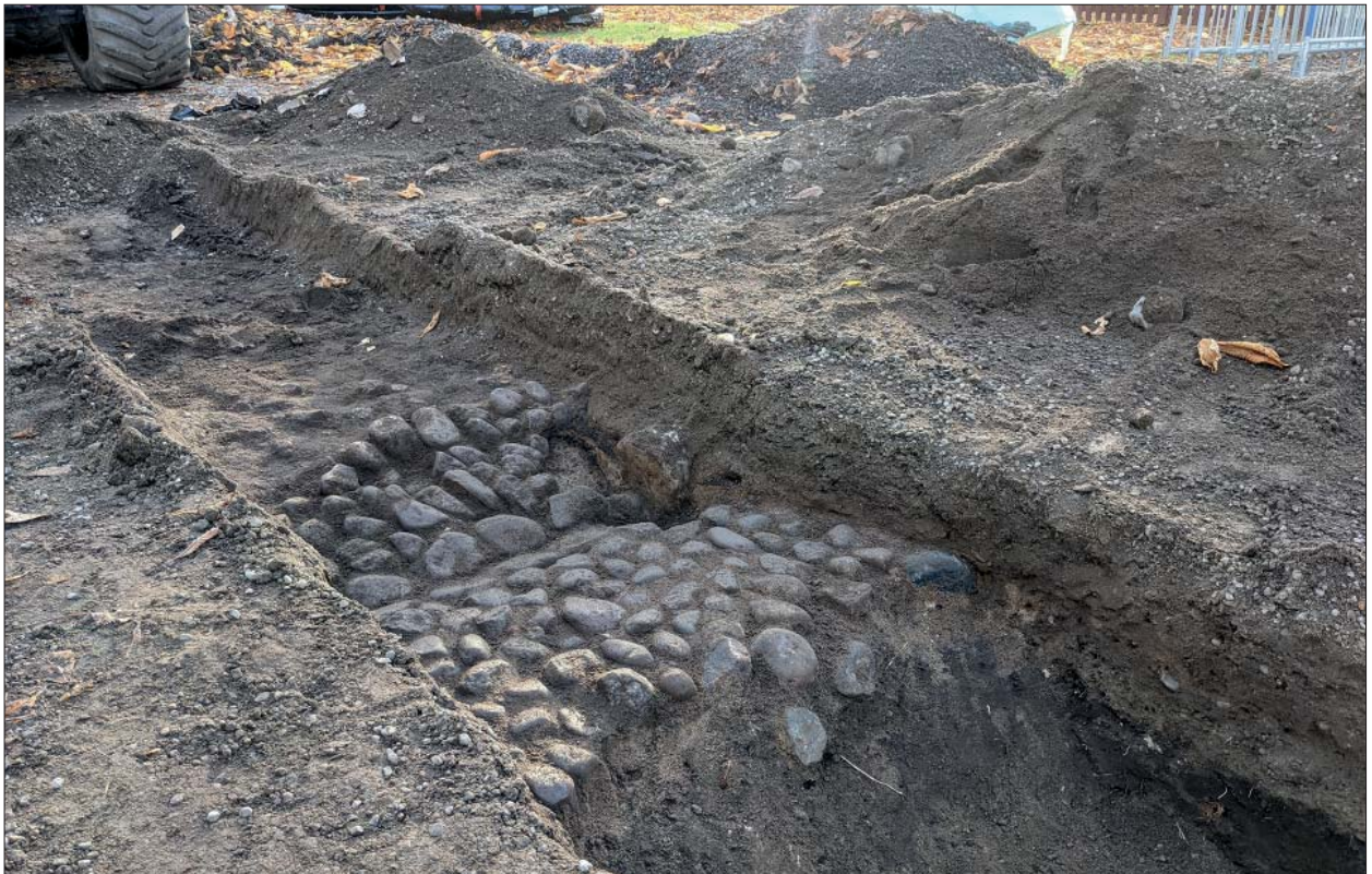
Figur 13. Stenläggning A474. Foto mot SV, Linnéa Hernqvist, ÖM.
