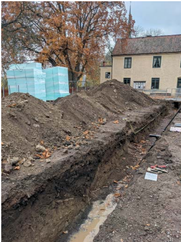
Figur 15. Dike A609/L17 profil 7. Foto mot NV, Linnéa Hernqvist, ÖM.
