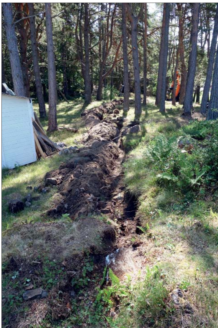
Figur 5. Kabelschaktet mot S. Foto Roger Lundgren, ÖM.
