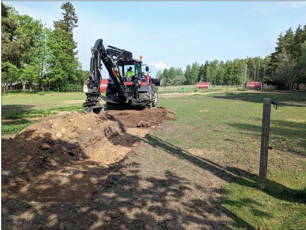
Figur 8. Undersökningsområdet vid Kårarp. Schakt S214 mot nordväst. Foto Roger Lundgren, ÖM.
