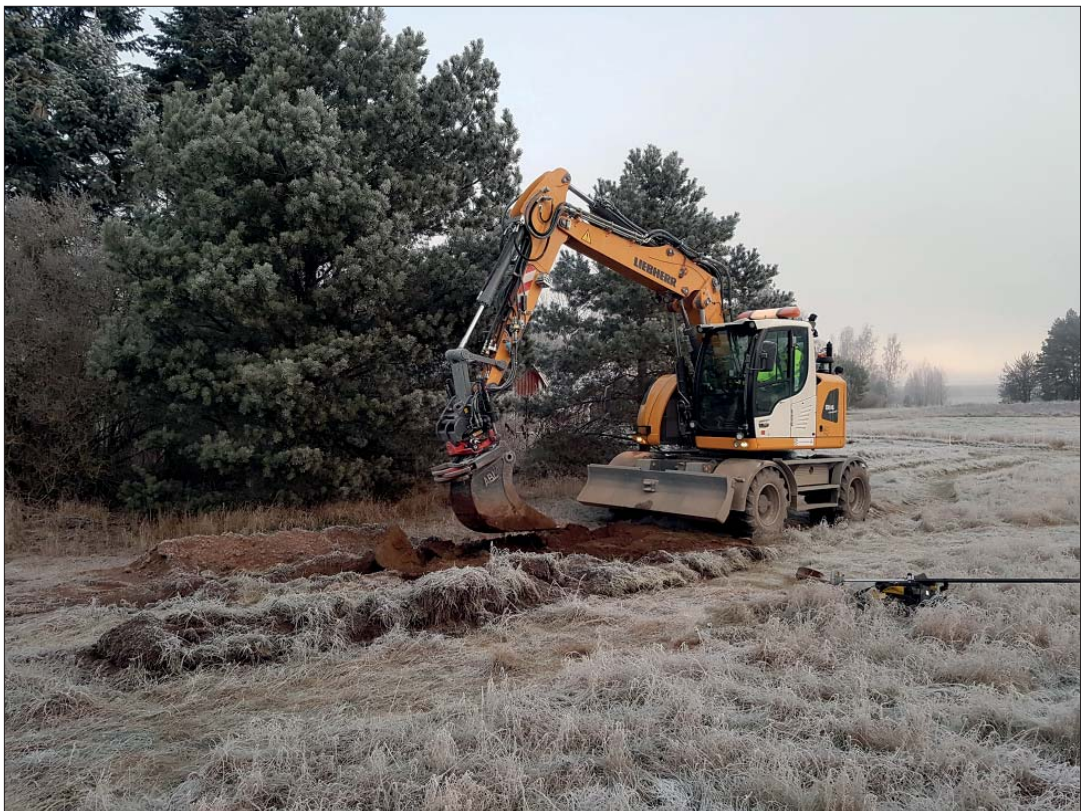
Schaktning vid Delsträcka 3, Sandkulla. Foto Anders Olofsson, ÖM.
