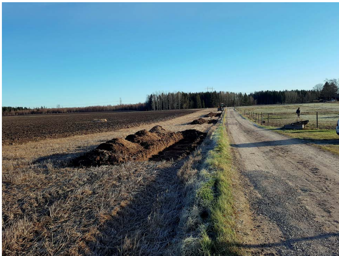
Schakt vid Delsträcka 1, Fagersberg. Foto från V, Anders Olofsson, ÖM.
