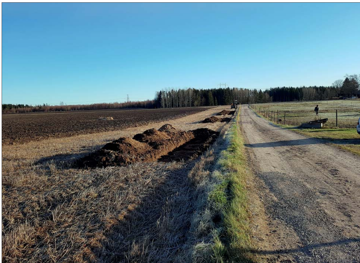
Figur 3. Schakt vid Delsträcka 1, Fagersberg. Foto från V, Anders Olofsson, ÖM.
