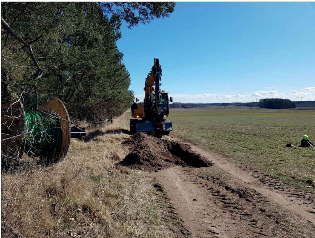
Schaktning vid Örnsnäs, Delsträcka 4. Foto från NV, Anders Olofsson, ÖM.
