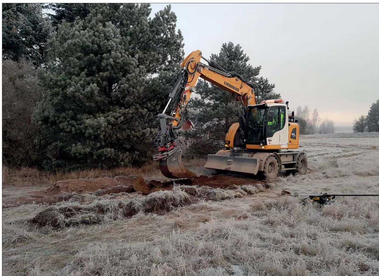
Figur 4. . Schaktning vid Delsträcka 3, Sandkulla. Foto Anders Olofsson, ÖM.
