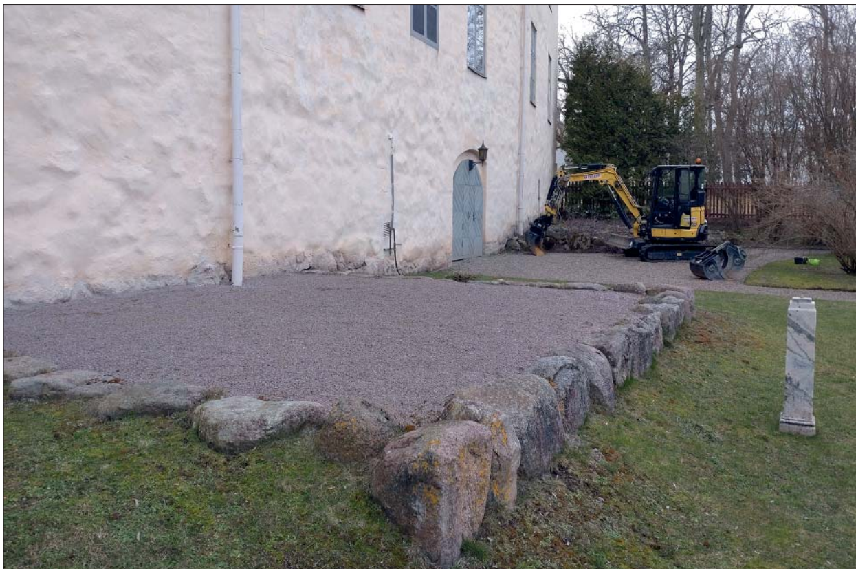
Figur 3. En torngrund som undersökts i Slottsträdgården har markerats med stenar och en grusad yta. I bakgrunden står grävmaskinen redo för att börja gräva fram den trasiga ledningen i anslutning till stupröret. Foto mot söder. Foto Ann-Charlott Feldt, ÖM.
